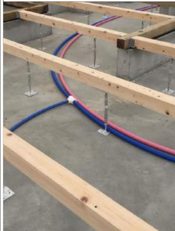
1-6□土台の防腐・防蟻処理材を用いる。（土台に接する外壁の下端には、水切りを設ける）(1/4)
