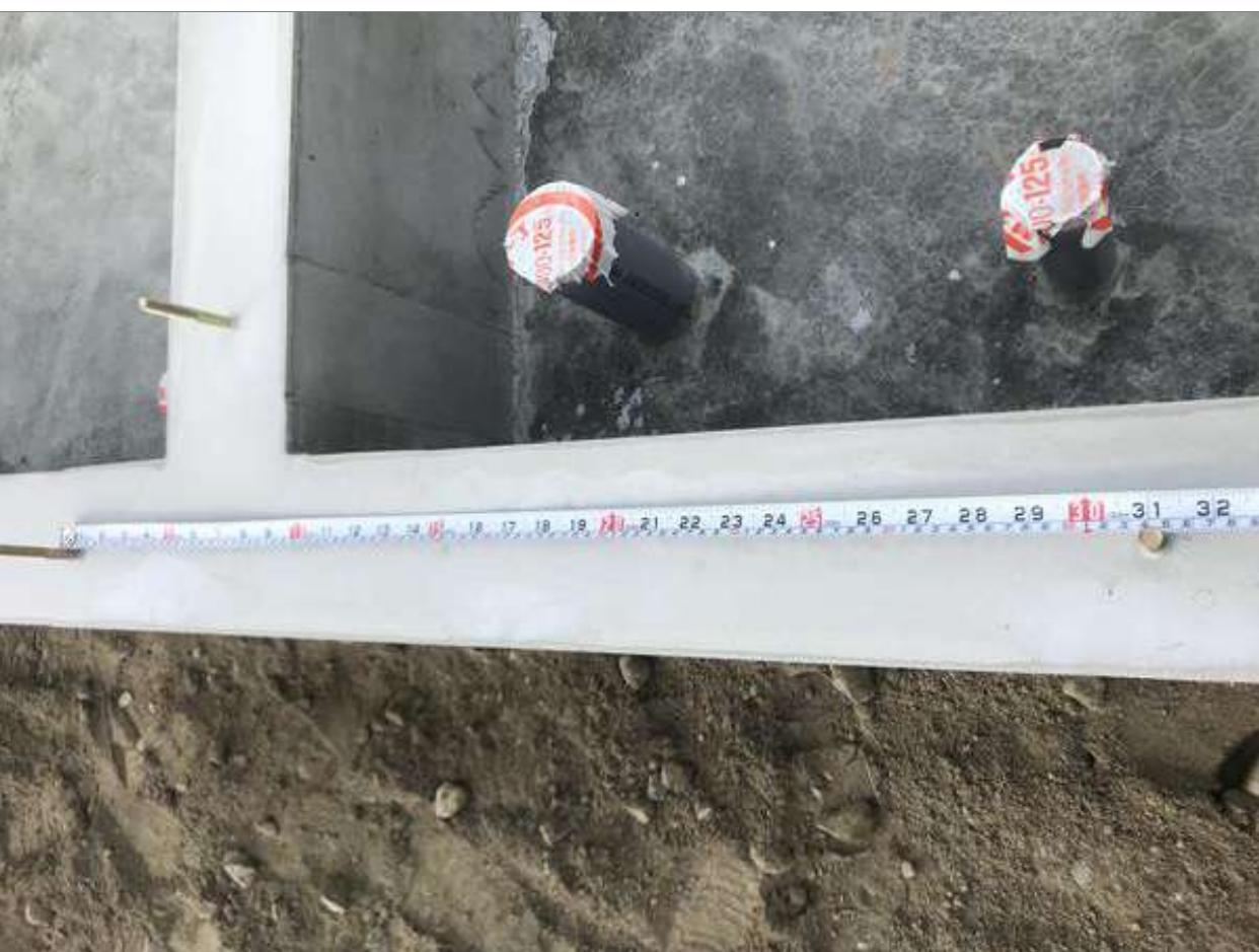
1-2□アンカーボルトのコンクリート埋込み長さは250mm以上とし、アンカーボルトの先端は土台の上端よりナットの外にねじが3山以上出るように固定する。
