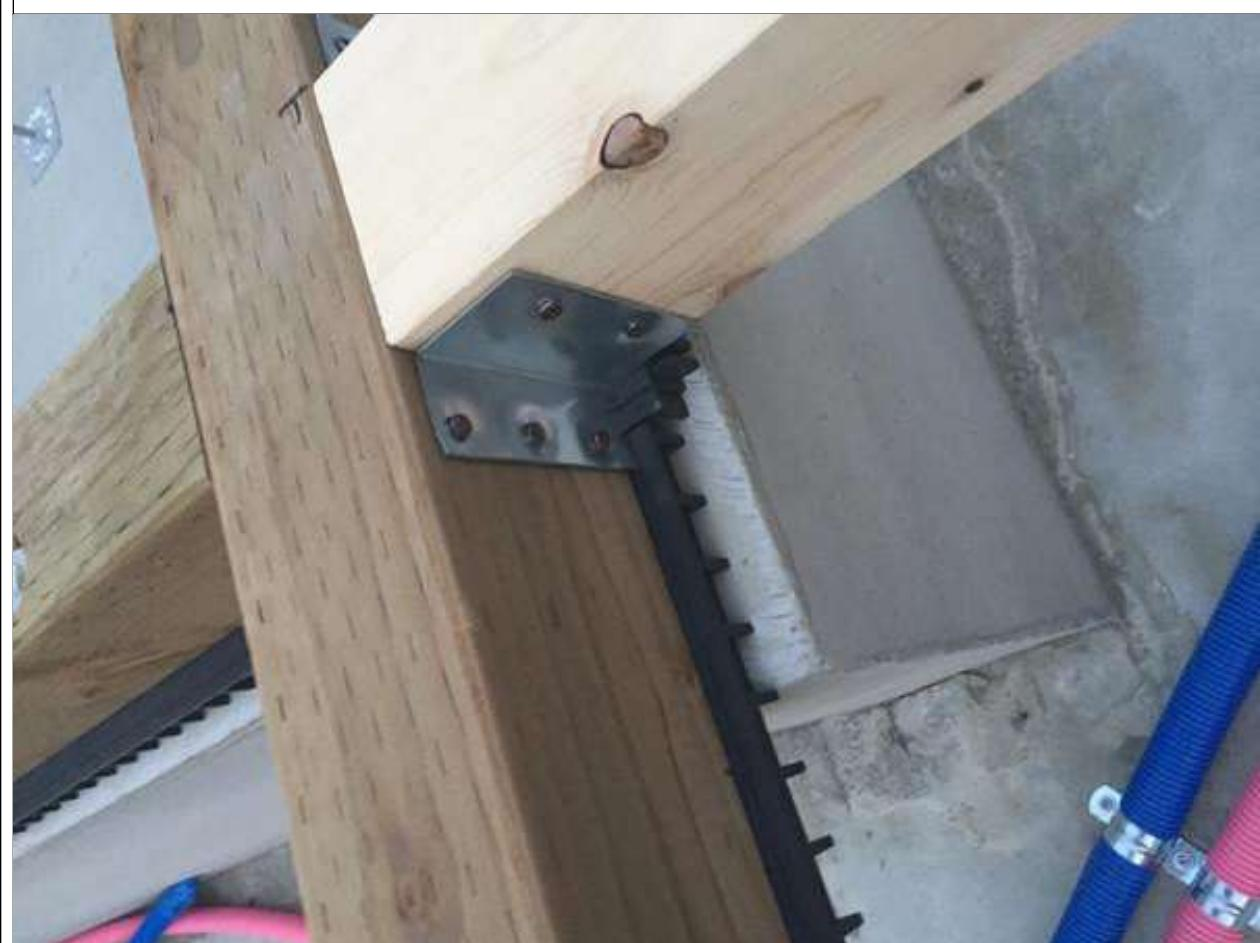
1-13□接合金物の種類・施工位置が図面通りか確認する。(2/2)
