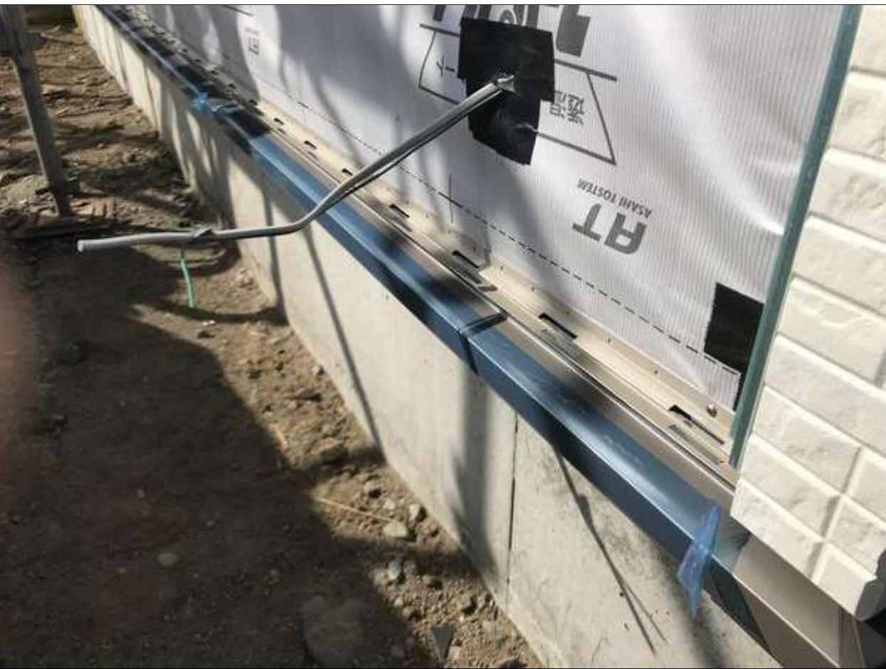
1-7□地面からの高さが1m以内の外壁の枠組の防腐・防蟻措置を現場で塗布・吹付をする。(1/4)
