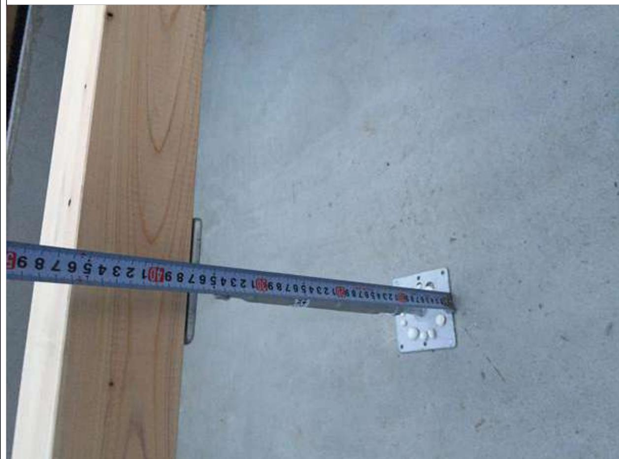
1-5□鋼製束施工前に基礎内を掃除機で掃除する。 鋼製束の間隔は前後左右1m以内を保ち、接着剤がはみ出るまで圧着する。(2/2)
