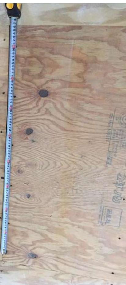
1-10 □外壁下張りの釘のピッチはメーカー仕様の壁倍率通りに施工する。
