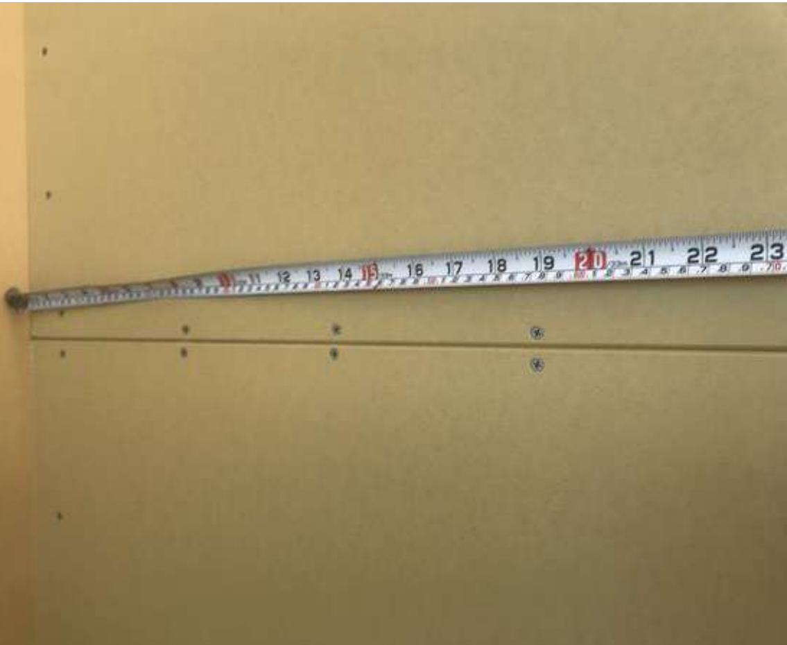
1-15 くぎ打ち間隔は外周100mm以内、中間部200mm以内の間隔で留め付ける。(2枚張りの場合) くぎ打ち間隔は外周部及び中間部とも200mm以内とする。(2/2)
