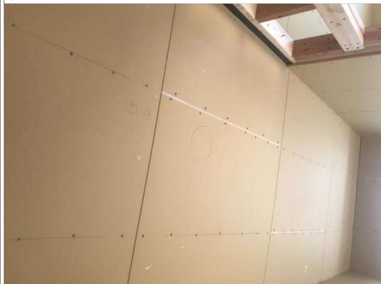
1-15 くぎ打ち間隔は外周100mm以内、中間部200mm以内の間隔で留め付ける。(2枚張りの場合) くぎ打ち間隔は外周部及び中間部とも200mm以内とする。(1/2)
