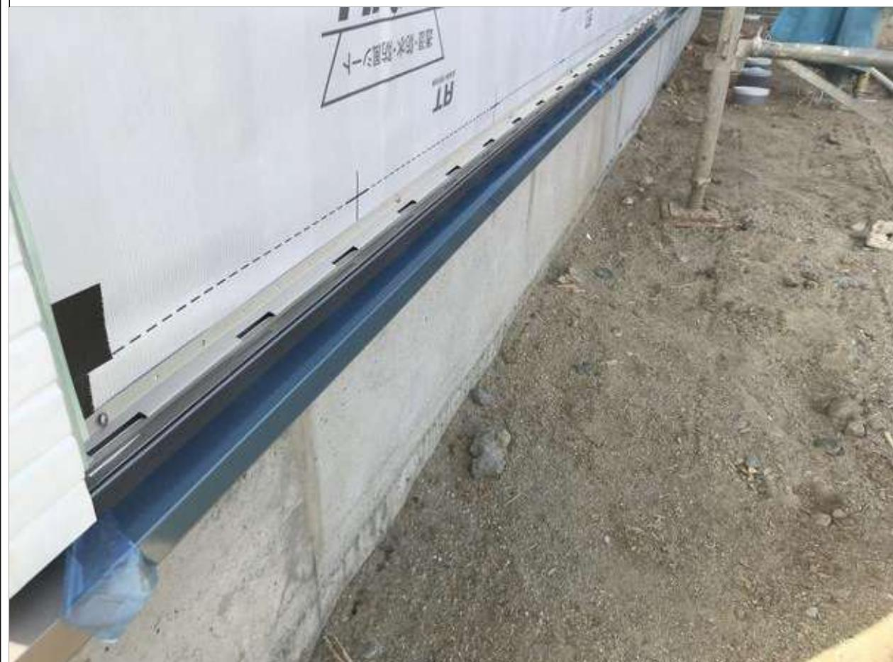
1-6□土台の防腐・防蟻処理材を用いる。(土台に接する外壁の下端には、水切りを設ける) (2/2)
