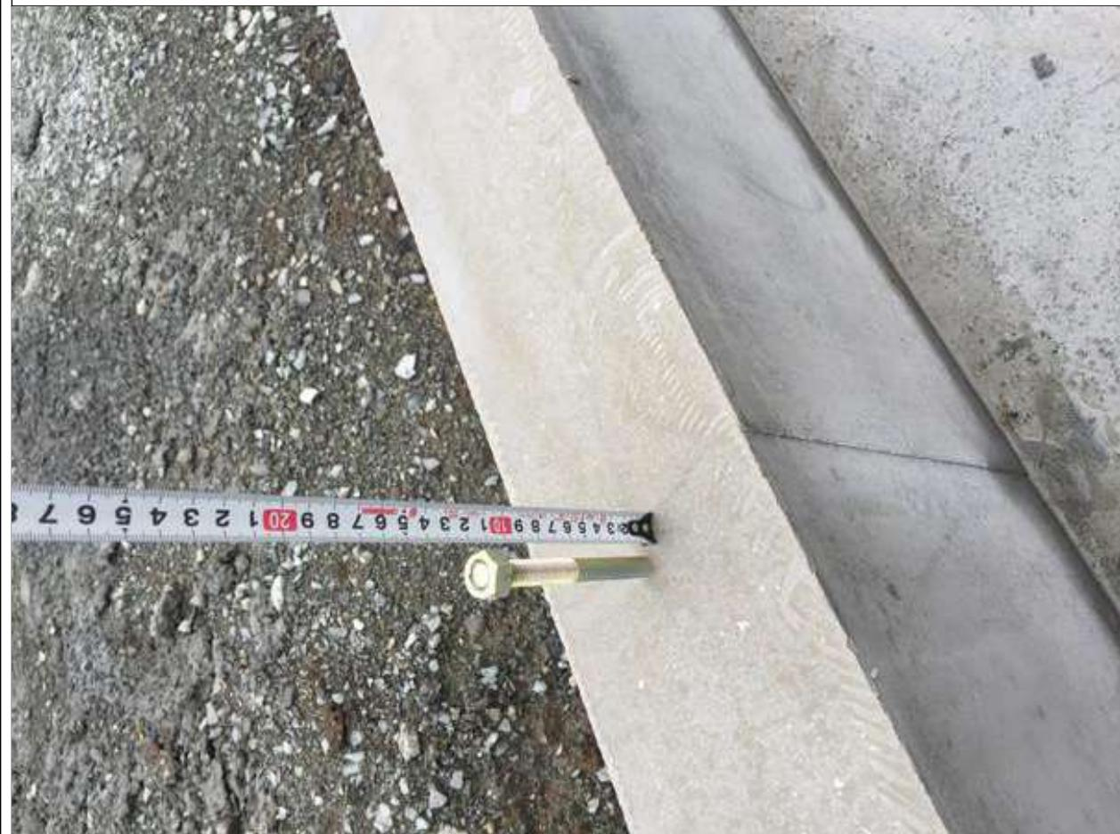
1-3口基礎天端の高さを水準器を使用し、水平確認する。天端レベルに合わせて調整パッキンを使用する。
