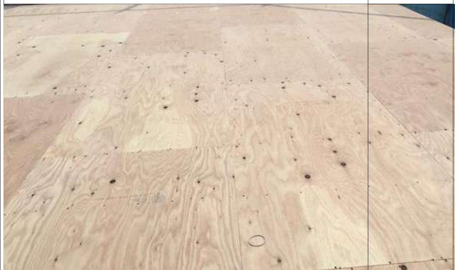
1-22 建て方当時にアスファルトルーフィングまで施工する。上下（流れ方向）は100mm以上、左右（長手方向）は200mm以上重ね合わせる。（未施工の場合、ブルーシート養生する）下屋と外壁の取り合い部に関しては、建て方時にアスファルトルーフィングを先行して差し込んでおく。（ルーフィング施工前に外し釘を確認）
