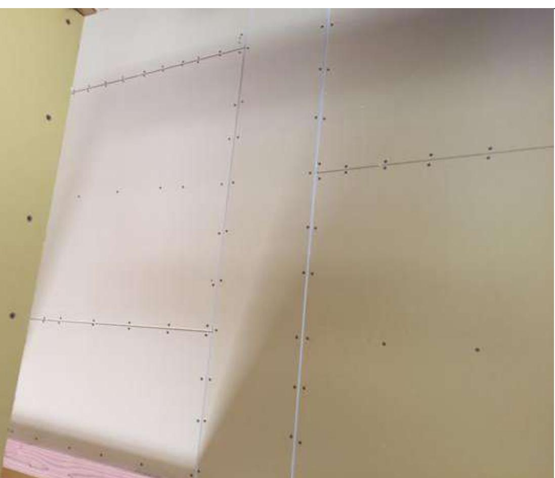
1-16 壁張りに用いるせっこうボードは、床面からの湿気により強度が低下しないように床面から13mm程度離して打ち付ける
