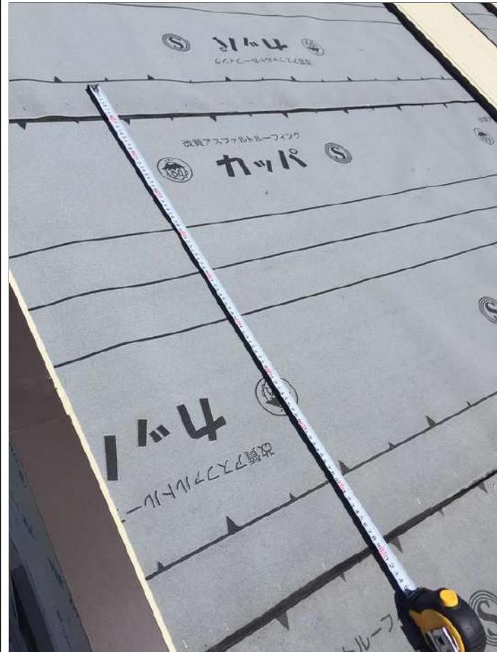
1-23 屋根ルーフィングの立ち上がり250mm以上確保し、上端は気密テープで圧着する。かつ雨押さえ上端より50mm以上とする
