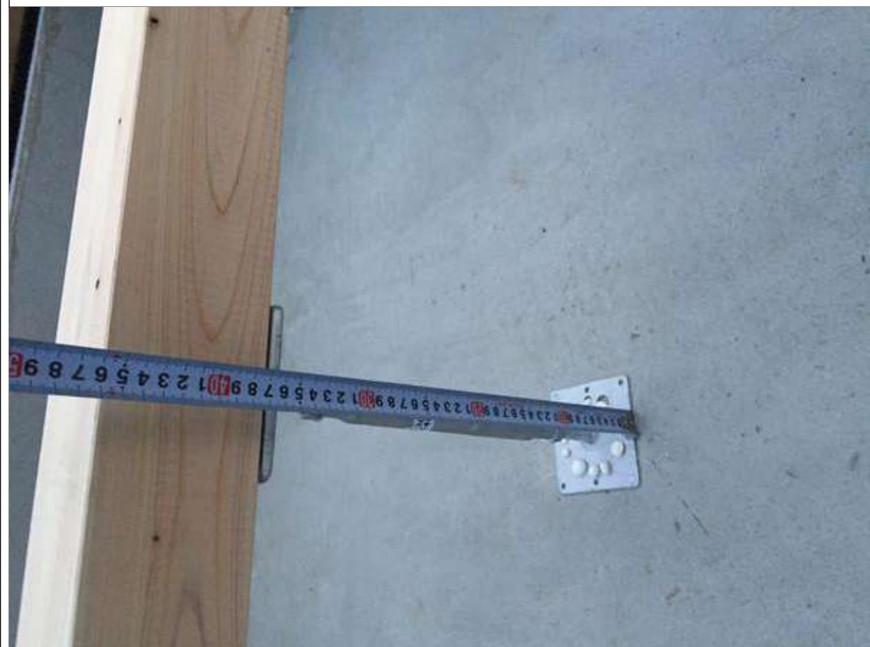
1-13 □接合金物の種類・施工位置が図面通りか確認する。(1/2)
