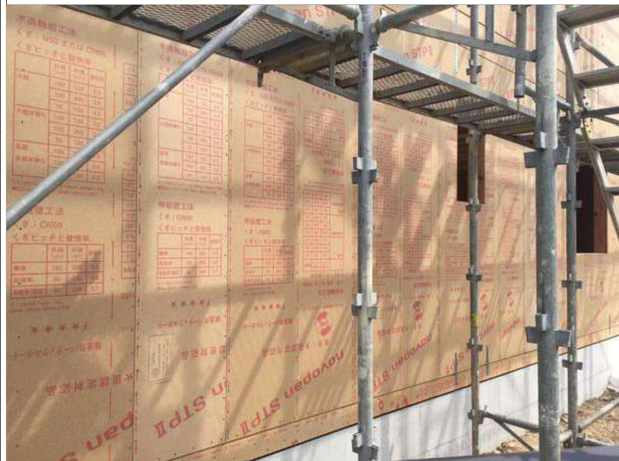
1-11 外壁下張りの釘のめり込み具合2mm以内か確認する。※デプスゲージにて沈み込みの確認。
