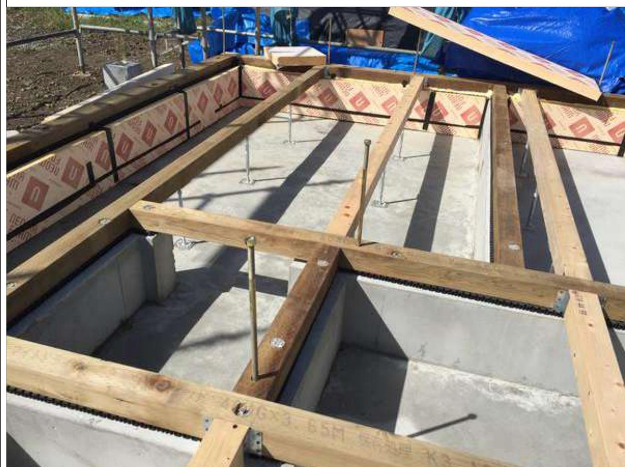
1-5□鋼製束施工前に基礎内を掃除機で掃除する。 鋼製束の間隔は前後左右1m以内を保ち、接着剤がはみ出るまで圧着する。
