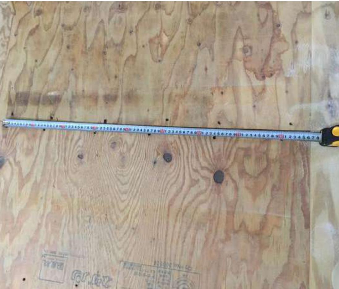
1-9□床下張材のくぎ打ちはCN50を周辺部150mm間隔以内、中間部200mm以内で平打ちする。床下張材の厚さが15mm以上の場合、CN65が望ましい。(2/2)
