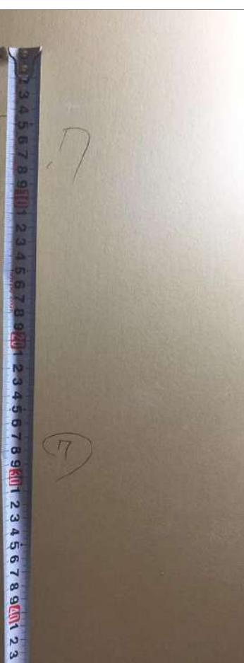
1-16 壁張りに用いるせっこうボードは、床面からの湿気により強度が低下しないように床面から13mm程度離して打ち付ける
