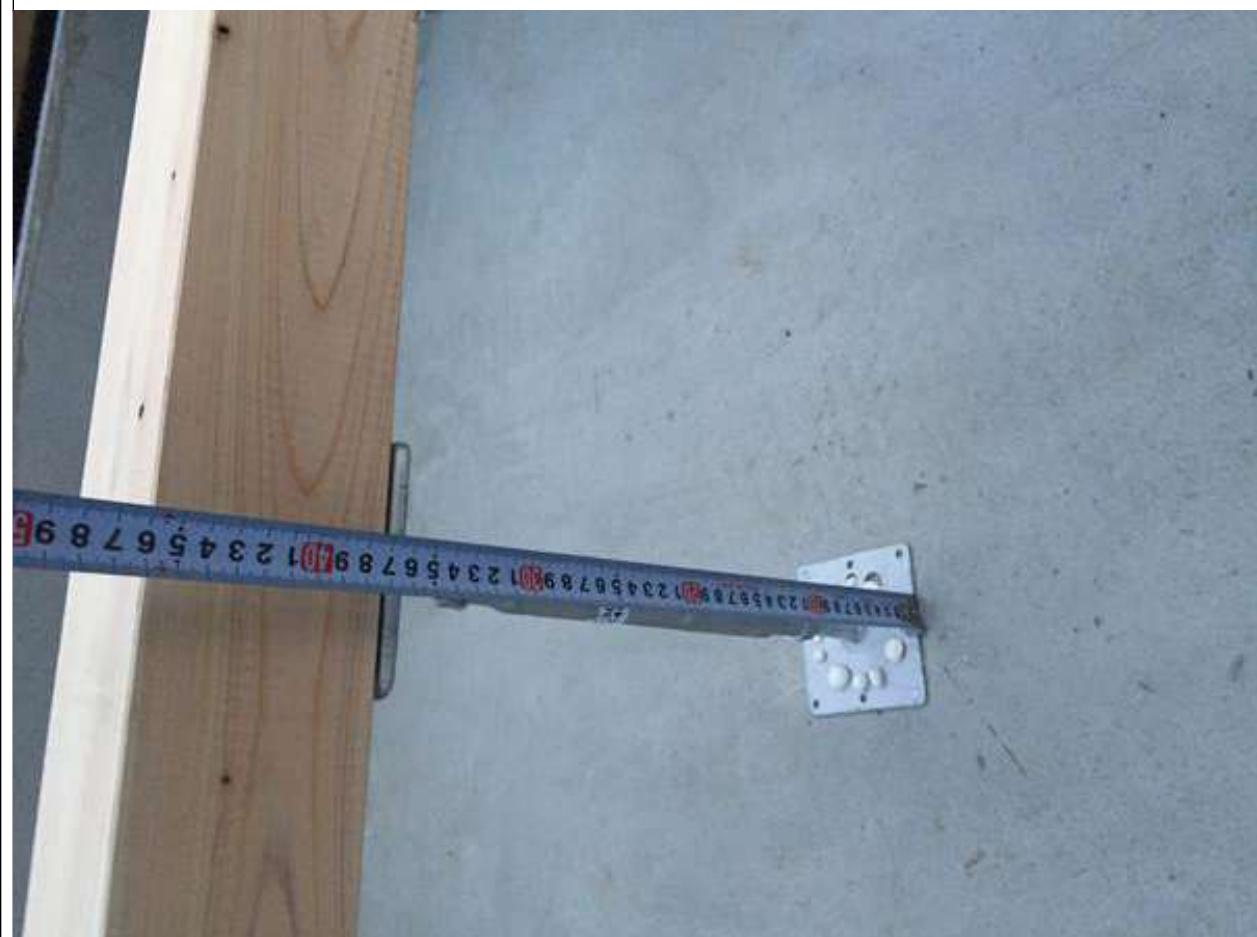
1-13 □接合金物の種類・施工位置が図面通りか確認する。
