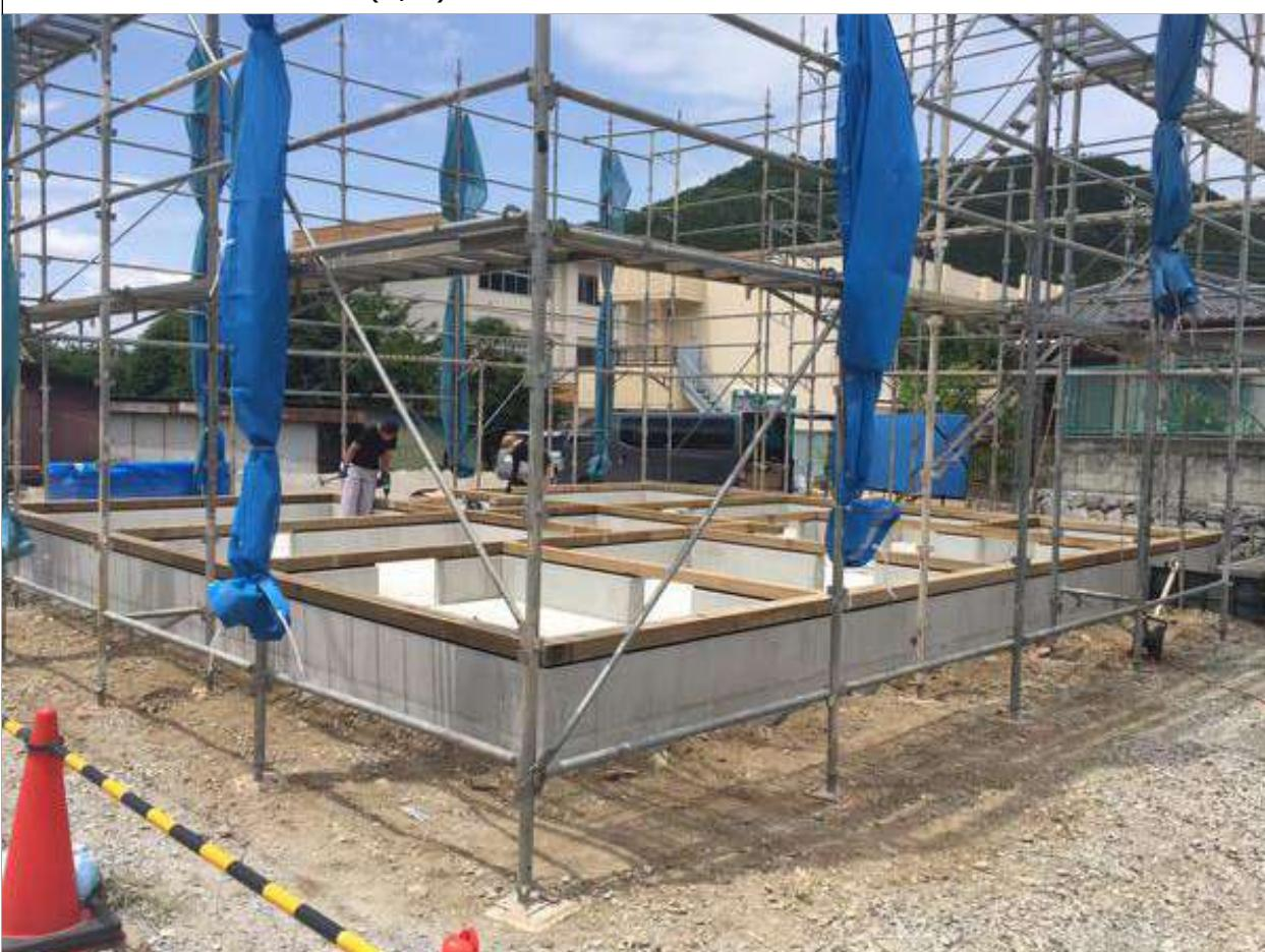
1-4□基礎パッキン・気密パッキン同土の隙間がないように敷き詰め、土台とパッキンの芯を一致させる。(2/2)
