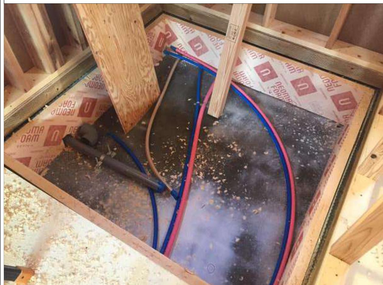
1-8□強度の低下、乾燥後の収縮による変形、シロアリ被害の増加、カビの発生を防ぐため、施工前に床合板の含水率は15%以下か確認する。
