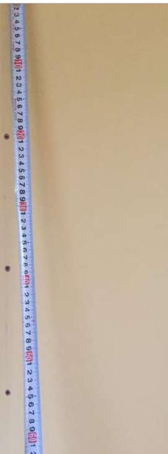
1-15 くぎ打ち間隔は外周100mm以内、中間部200mm以内の間隔で留め付ける。(2枚張りの場合) くぎ打ち間隔は外周部及び中間部とも200mm以内とする。(2/2)
