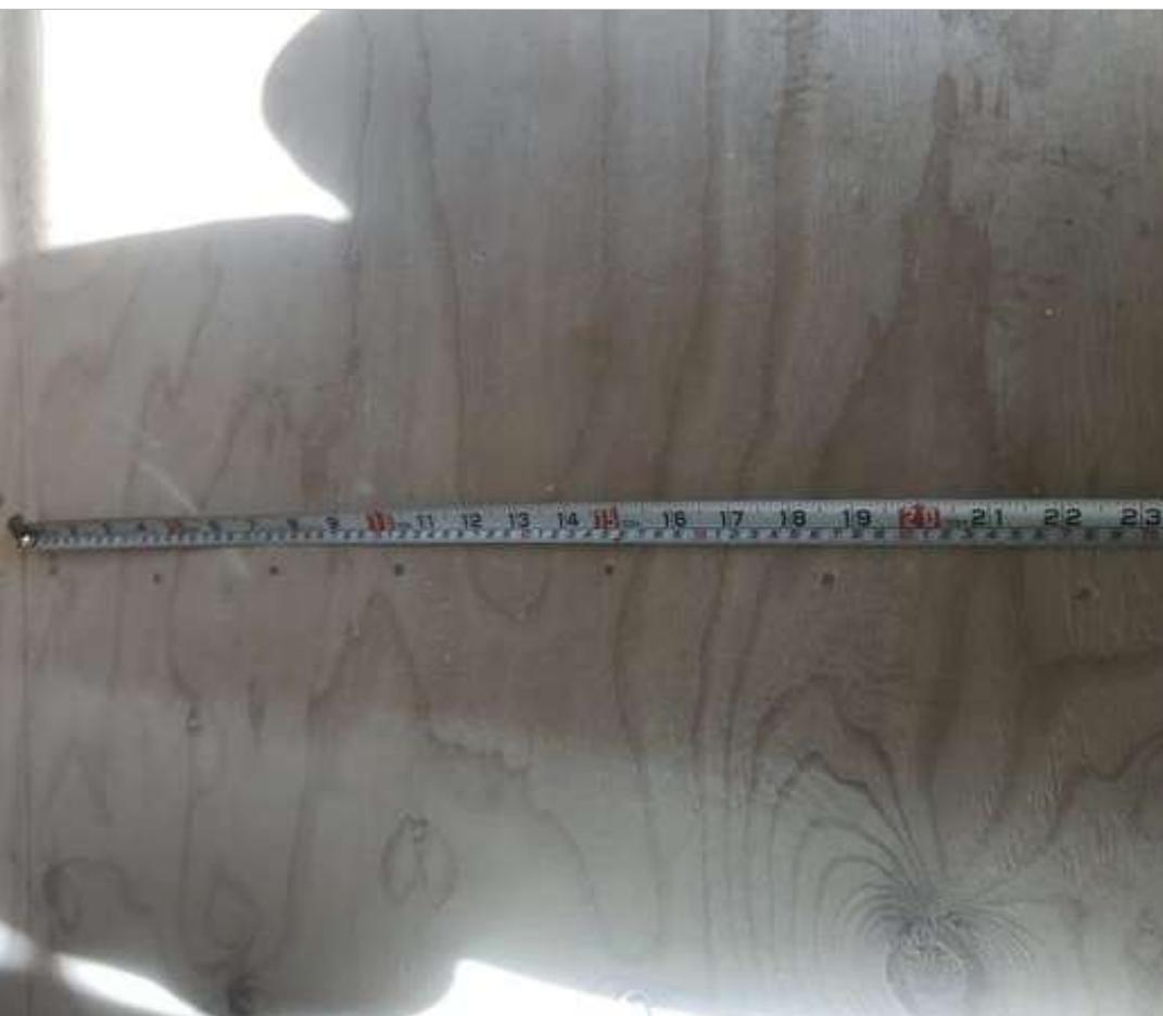
1-10□外壁下張りの釘のピッチはメーカー仕様の壁倍率通りに施工する。
