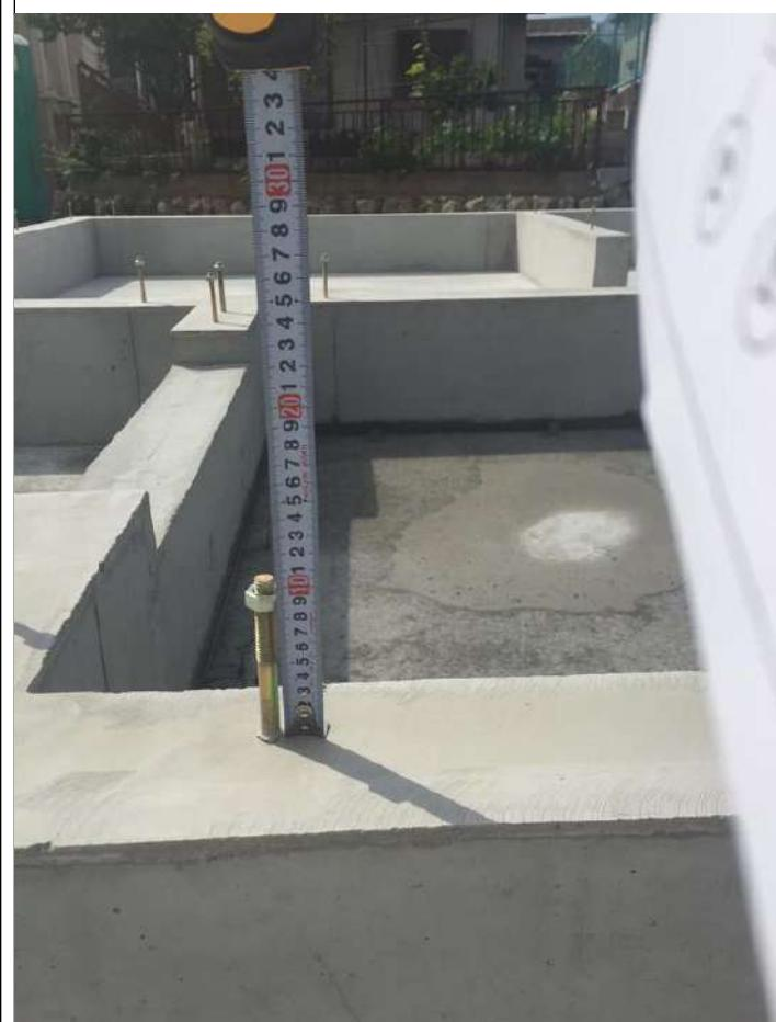
1-3□基礎天端の高さを水準器を使用し、水平確認する。天端レベルに合わせて調整パッキンを使用する。
