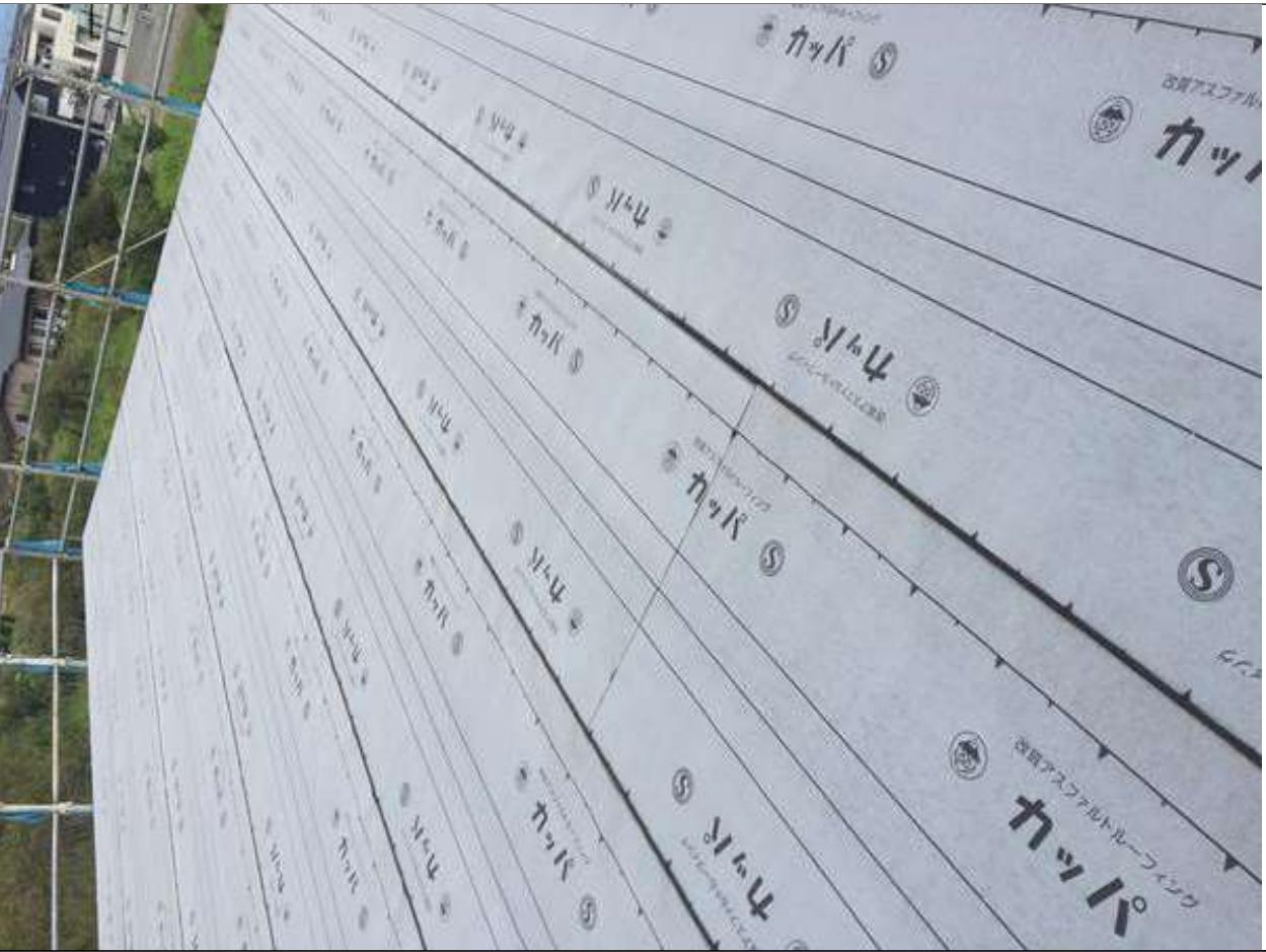
1-23 屋根ルーフィングの立ち上がり250mm以上確保し、上端は気密テープで圧着する。かつ雨押さえ上端より50mm以上とする
