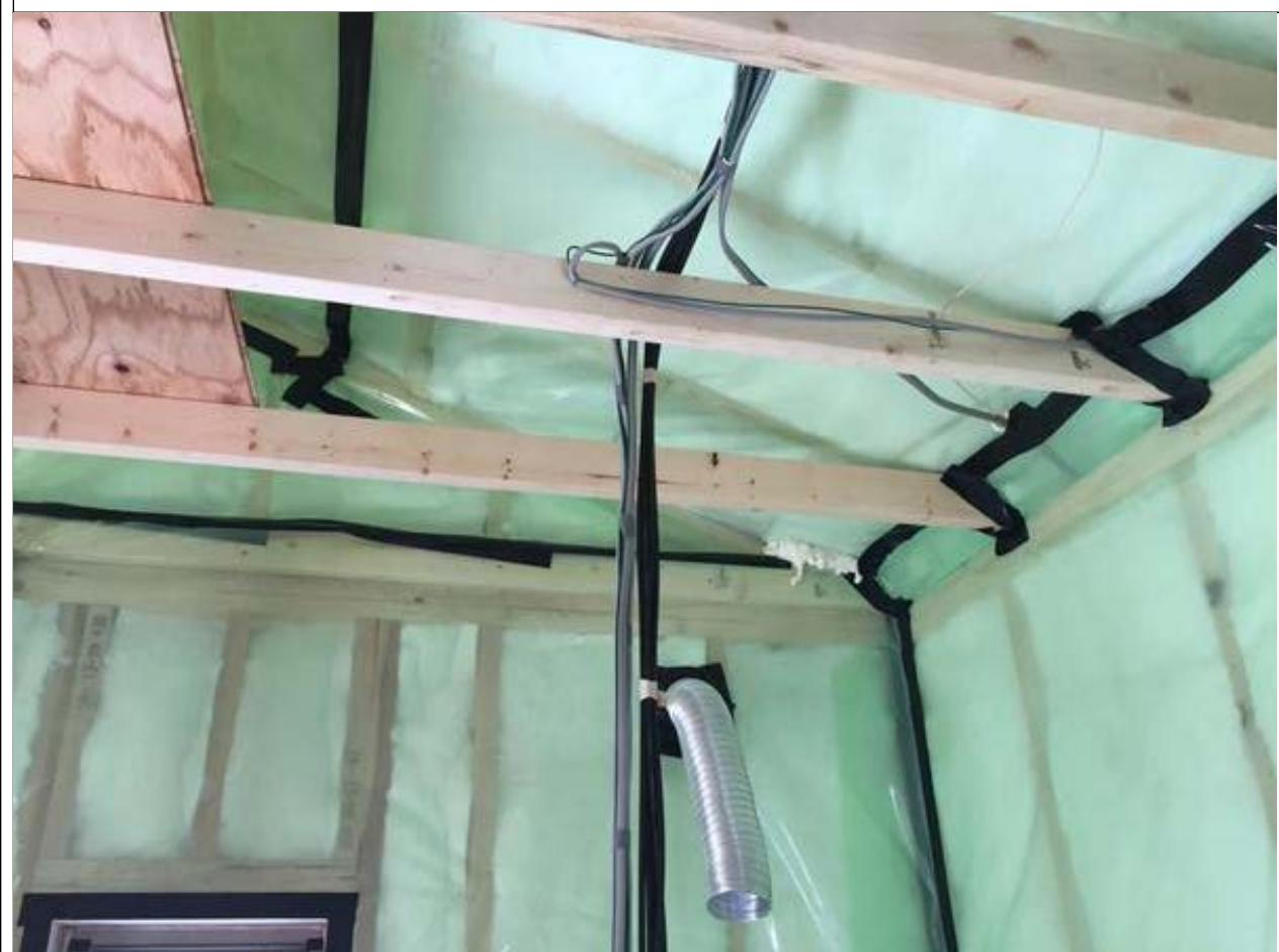
2-3□断熱材は隙間・欠損・施工不良がないように施工する。 断熱材は配管部分
