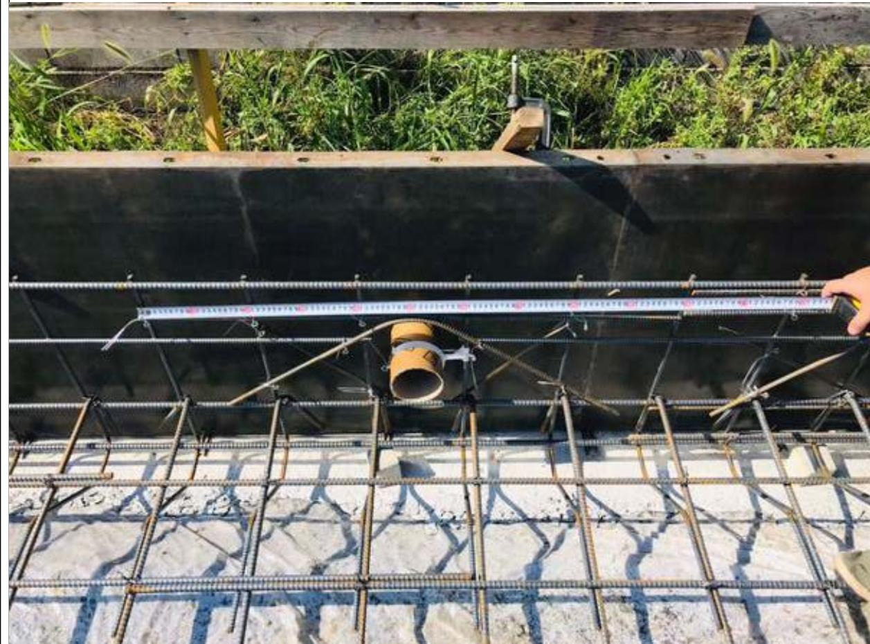
2-15 配管周囲（各スリーブ）の鉄筋との間隔は30mm以上確保する。
