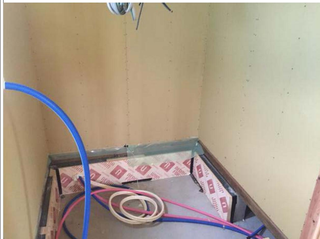
2-5□防湿層（気密シート）は幅広の長尺シートを用い、連続させ、隙間の出ないように施工する。継ぎ目は下地材のある所で30mm以上重ね合わせる。(1/2)
