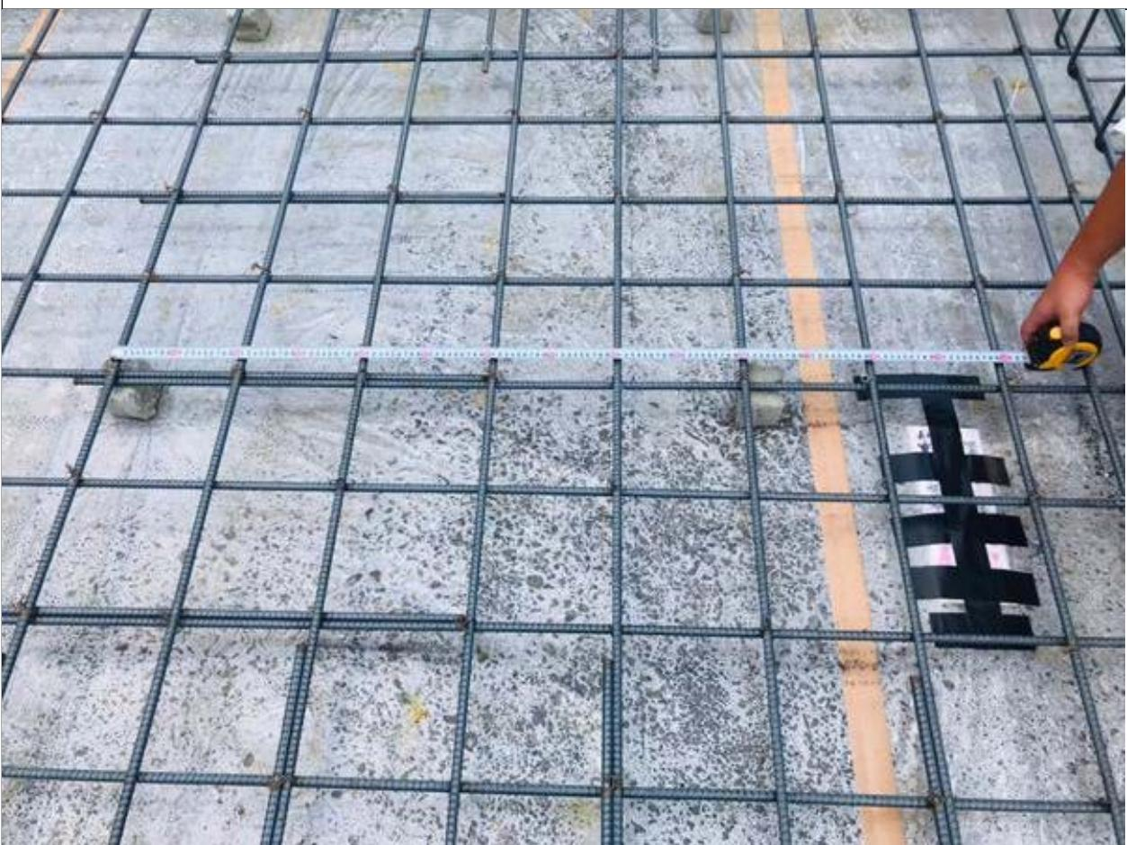
2-8 底盤鉄筋サイコロ（スペンサーブロック）を使いかぶり厚さ60mm以上か
