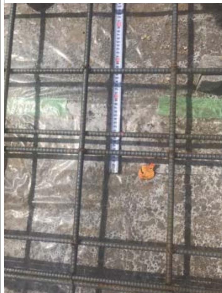
2-3 鉄筋の継手、定着は40d以上とする。参考：D13の場合 520mm
