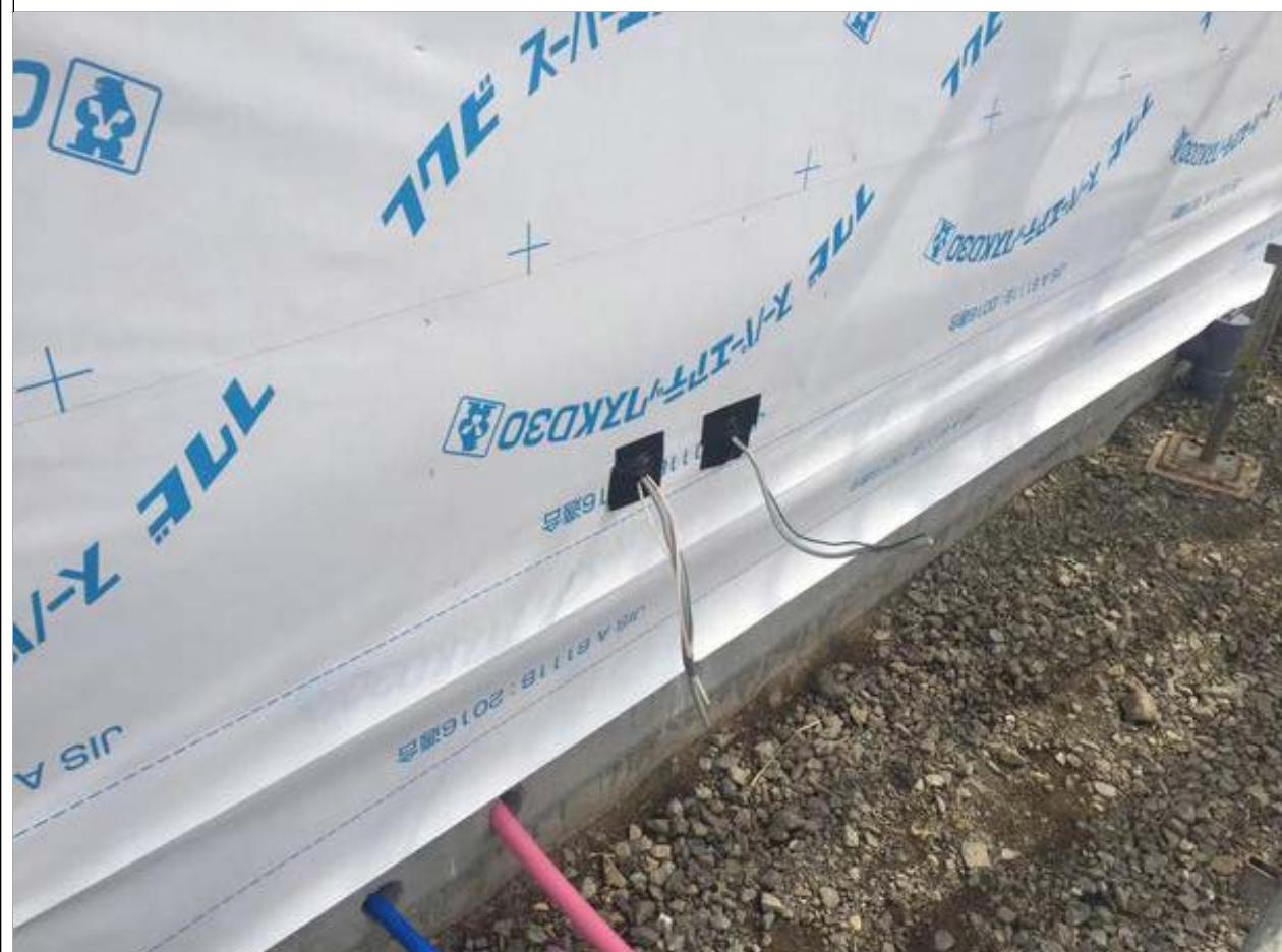
3-8□土台水切り・雨押さえに防水シートを端部に密着させる。
