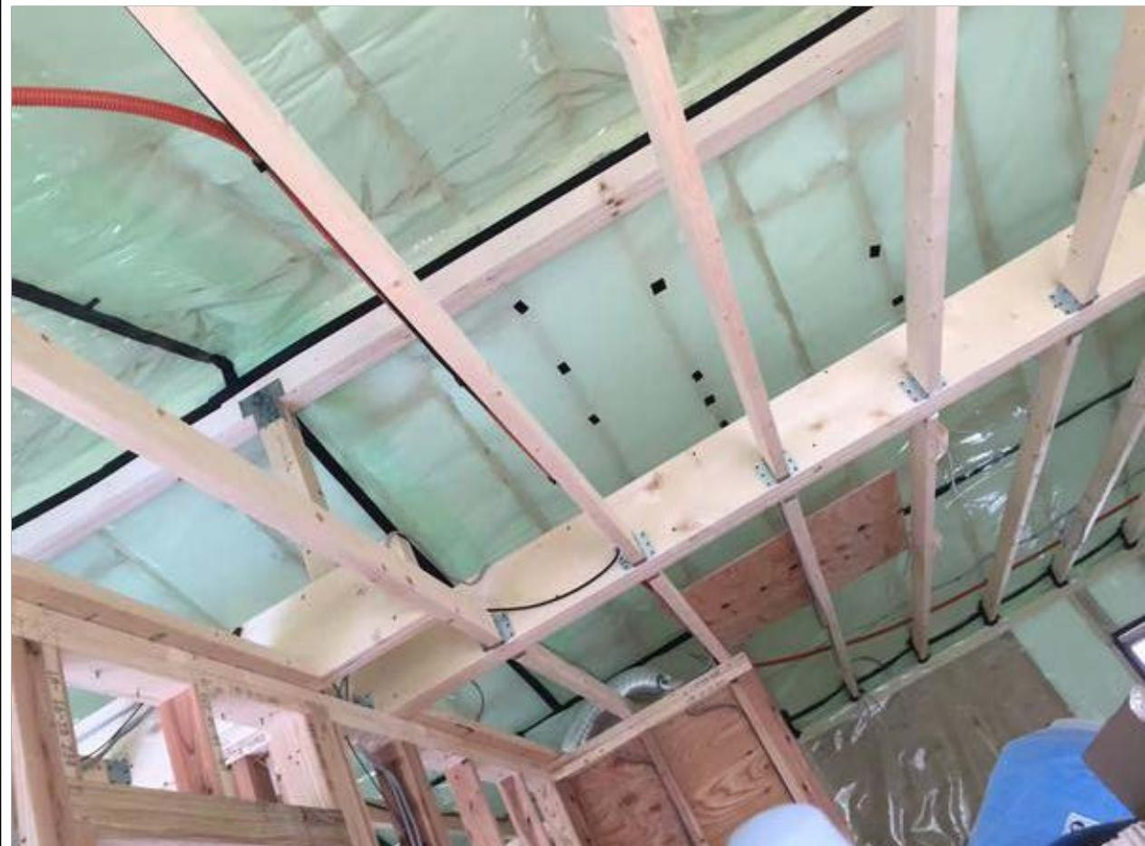
2-5□防湿層（気密シート）は幅広の長尺シートを用い、連続させ、隙間の出ないように施工する。継ぎ目は下地材のある所で30mm以上重ね合わせる。(2/2)
