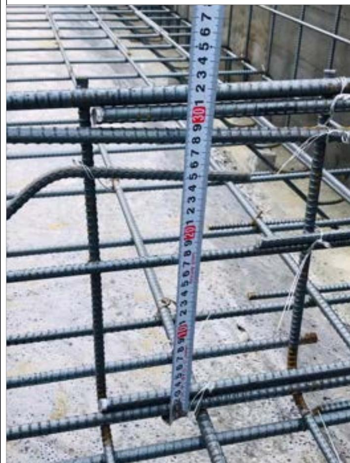
2-14 スリーブ管周辺の切断した主筋と同径の鉄筋を追加し、端部から補強筋の定着長さを40d以上確保する。
