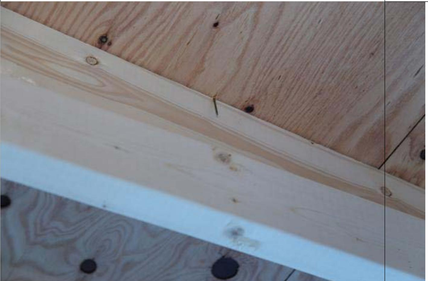
1-19 内側から見て屋根に外し釘がないか確認する。釘は合板端部より10～15mm離す。(4/4)
