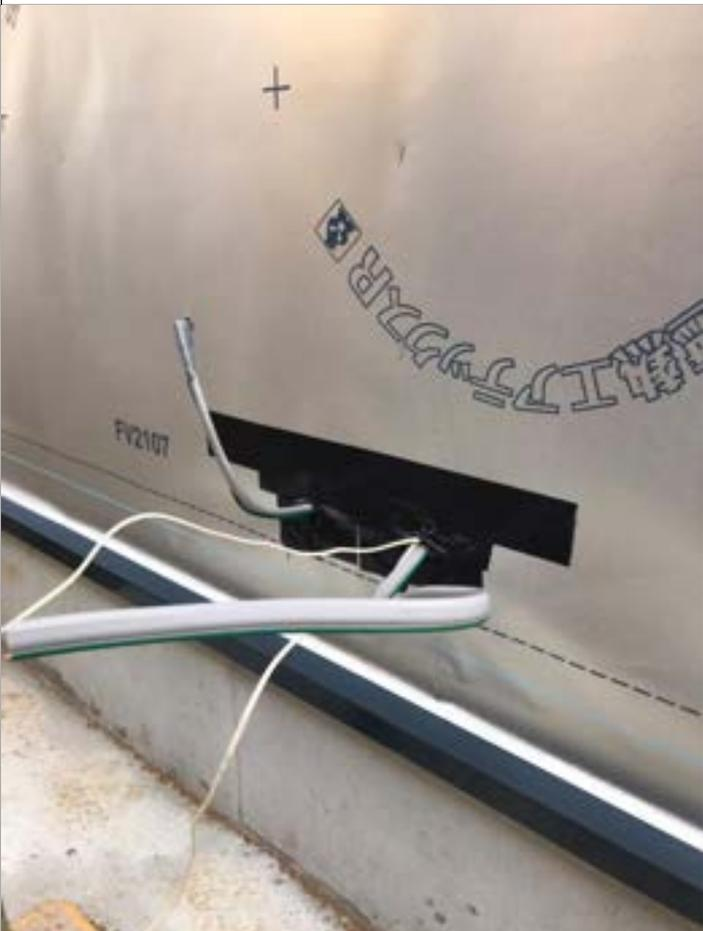
3-8口土台水切り・雨押さえに防水シートを端部に密着させる。
