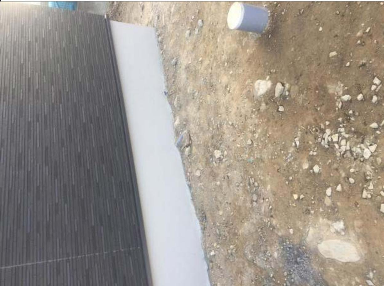
1-2口基礎配管部分へのコーキング措置をする。(1/2)
