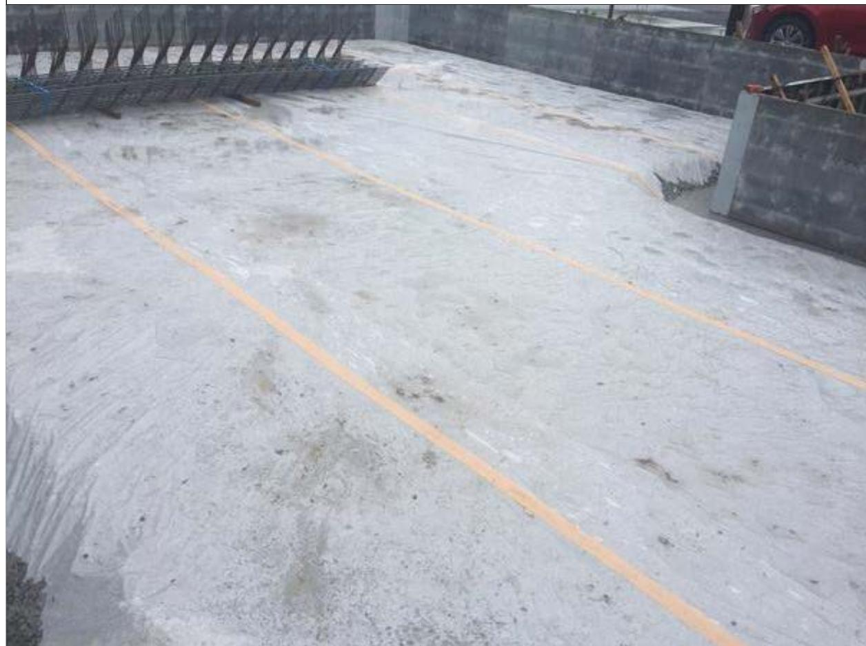
2-2 防湿フィルムの重ね幅は最低でも 150mm以上とし、防湿フィルムの全面を乾燥した砂、砂利又はコンクリート押さえとする。
