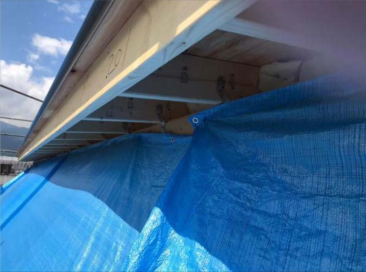
1-13口接合金物の種類・施工位置が図面通りか確認する。(2/2)
