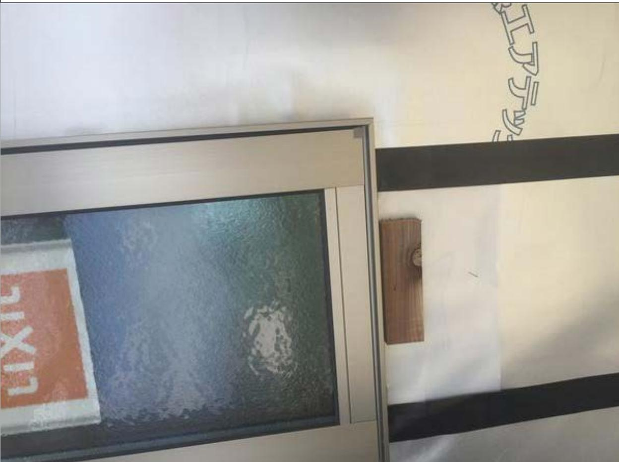
2-5口防湿層（気密シート）は幅広の長尺シートを用い、連続させ、隙間の出ないように施工する。継ぎ目は下地材のある所で30mm以上重ね合わせる。
