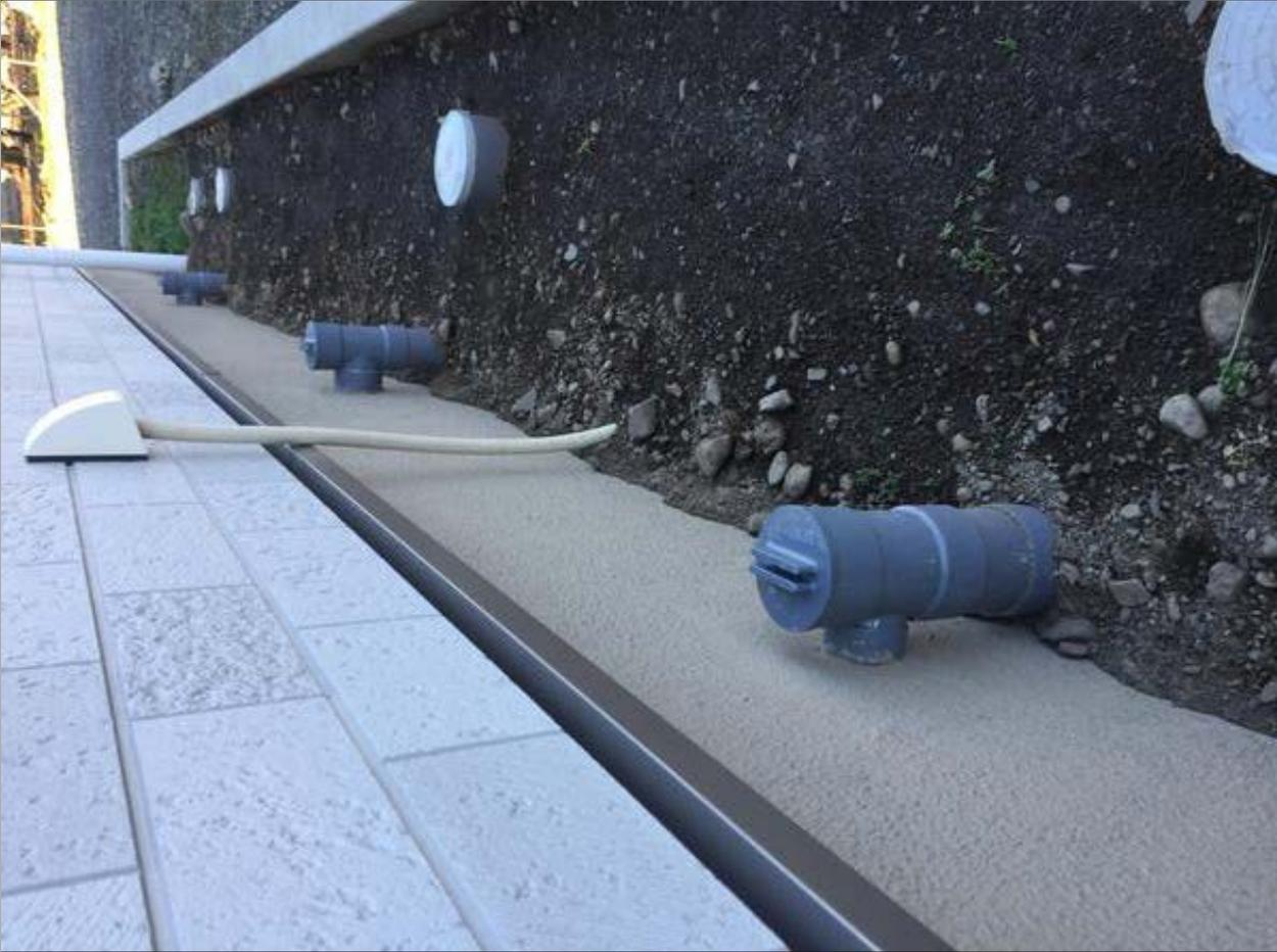
1-2口基礎配管部分へのコーキング措置をする。(2/2)
