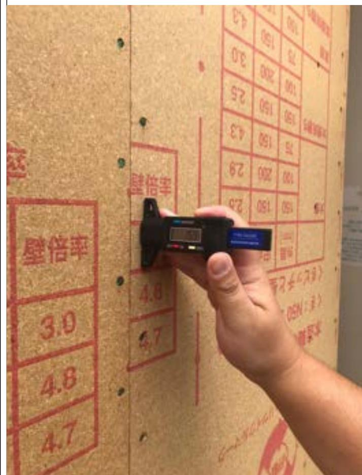
1-13口接合金物の種類・施工位置が図面通りか確認する。(1/2)
