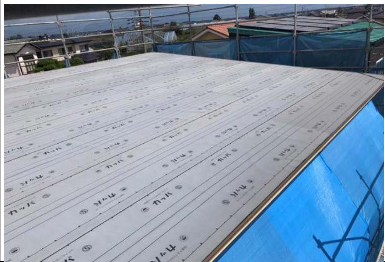
1-22 建て方当時にアスファルトルーフィングまで施工する。上下（流れ方向）は100mm以上、左右（長手方向）は200mm以上重ね合わせる。（未施工の場合、ブルーシート養生する）下屋と外壁の取り合い部に関しては、建て方時にアスファルトルーフィングを先行して差し込んでおく。（ルーフィング施工前に外し釘を確認）(2/2)
