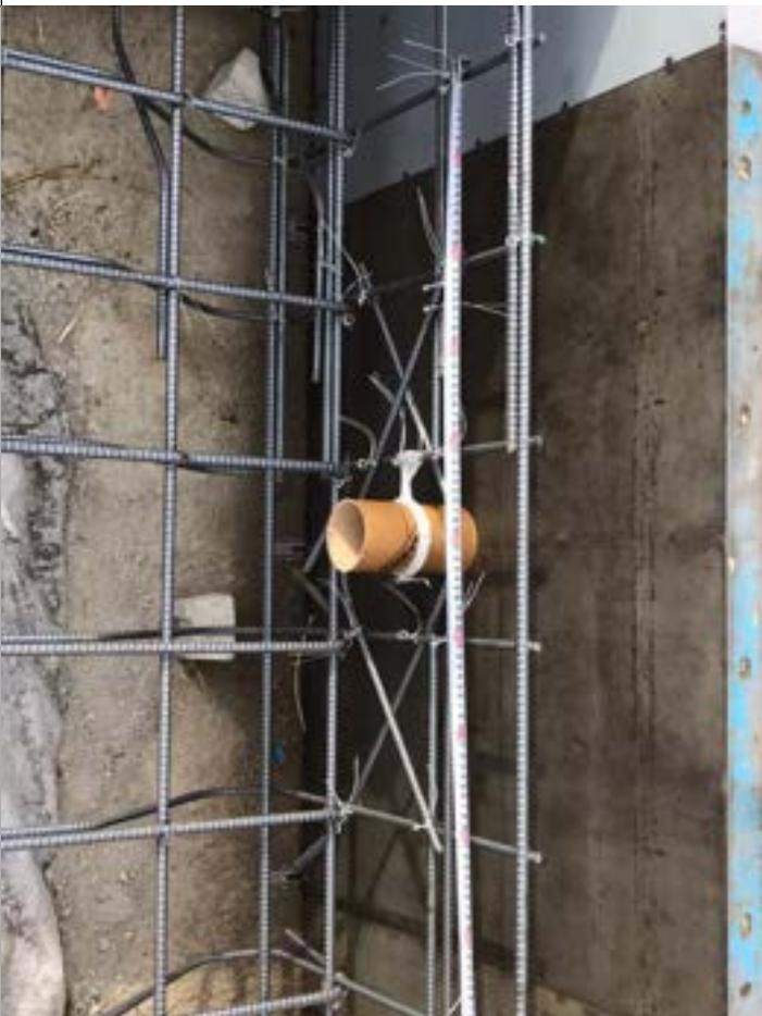
2-15 配管周囲（各スリーブ）の鉄筋との間隔は30mm以上確保する。
