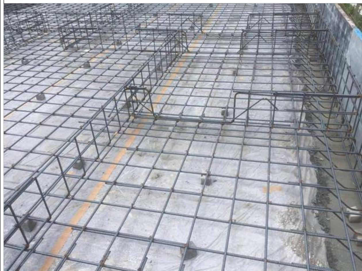
2-14 スリーブ管周辺の切断した主筋と同径の鉄筋を追加し、端部から補強筋の定着長さを40d以上確保する。
