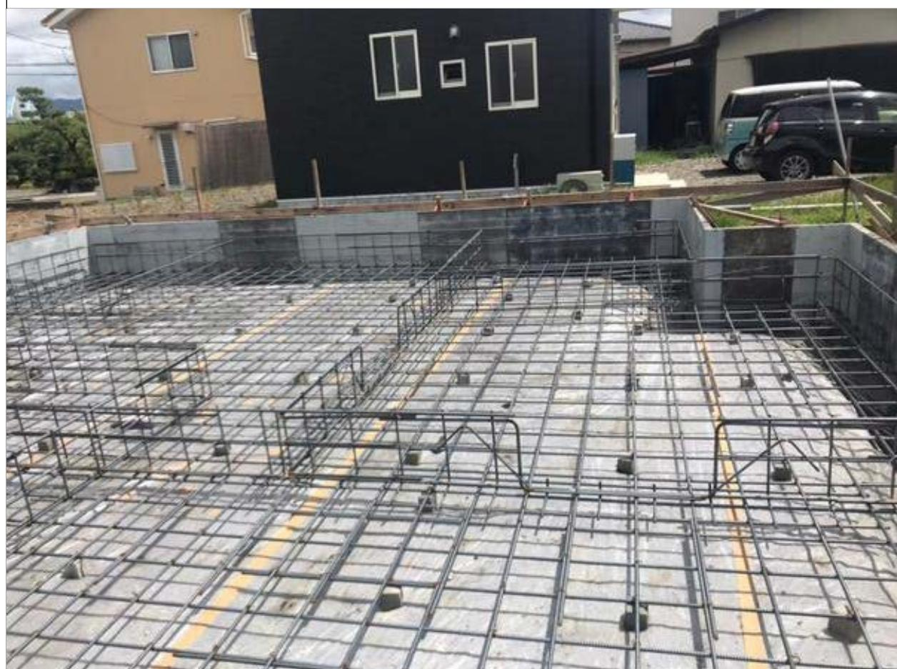
2-3 鉄筋の継手、定着は40d以上とする。参考:D13の場合 520mm
