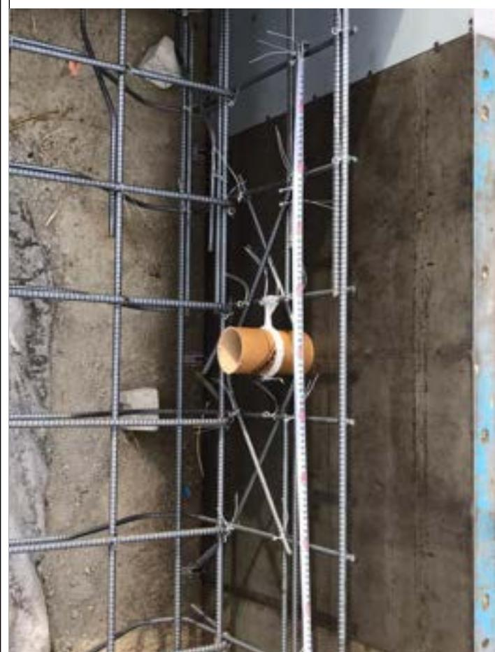
2-15 配管周囲（各スリーブ）の鉄筋との間隔は30mm以上確保する。
