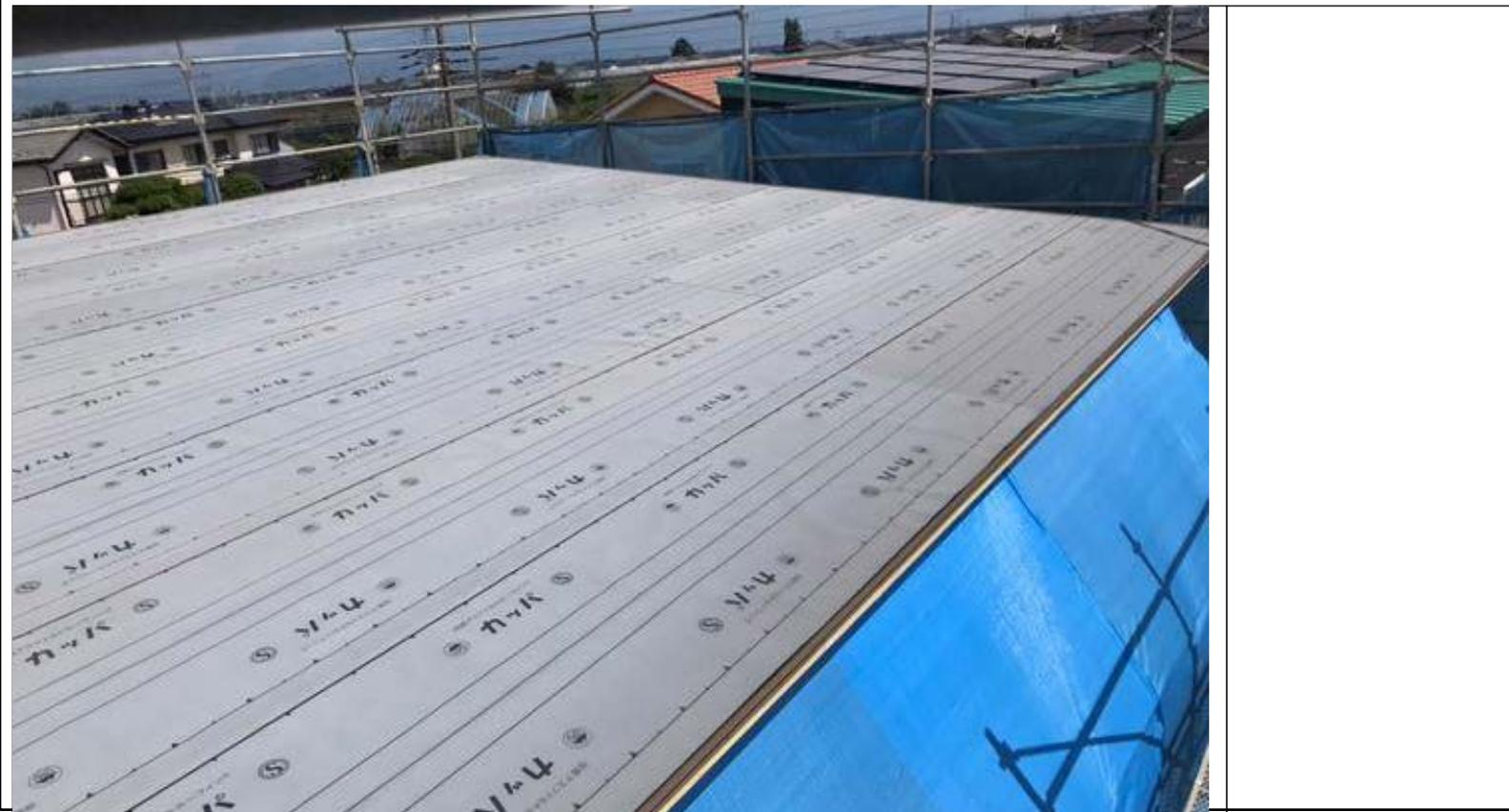
1-22 建て方当時にアスファルトルーフィングまで施工する。上下（流れ方向）は100mm以上、左右（長手方向）は200mm以上重ね合わせる。（未施工の場合、ブルーシート養生する）下屋と外壁の取り合い部に関しては、建て方時にアスファルトルーフィングを先行して差し込んでおく。（ルーフィング施工前に外し釘を確認）(2/2)
