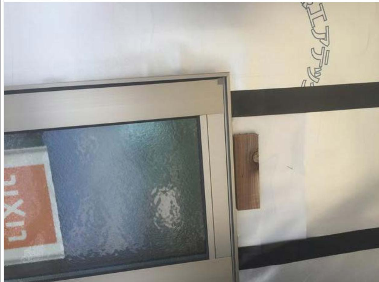
2-5□防湿層（気密シート）は幅広の長尺シートを用い、連続させ、隙間の出ないように施工する。 繰ぎ目は下地材のある所で30mm以上重ね合わせる。
