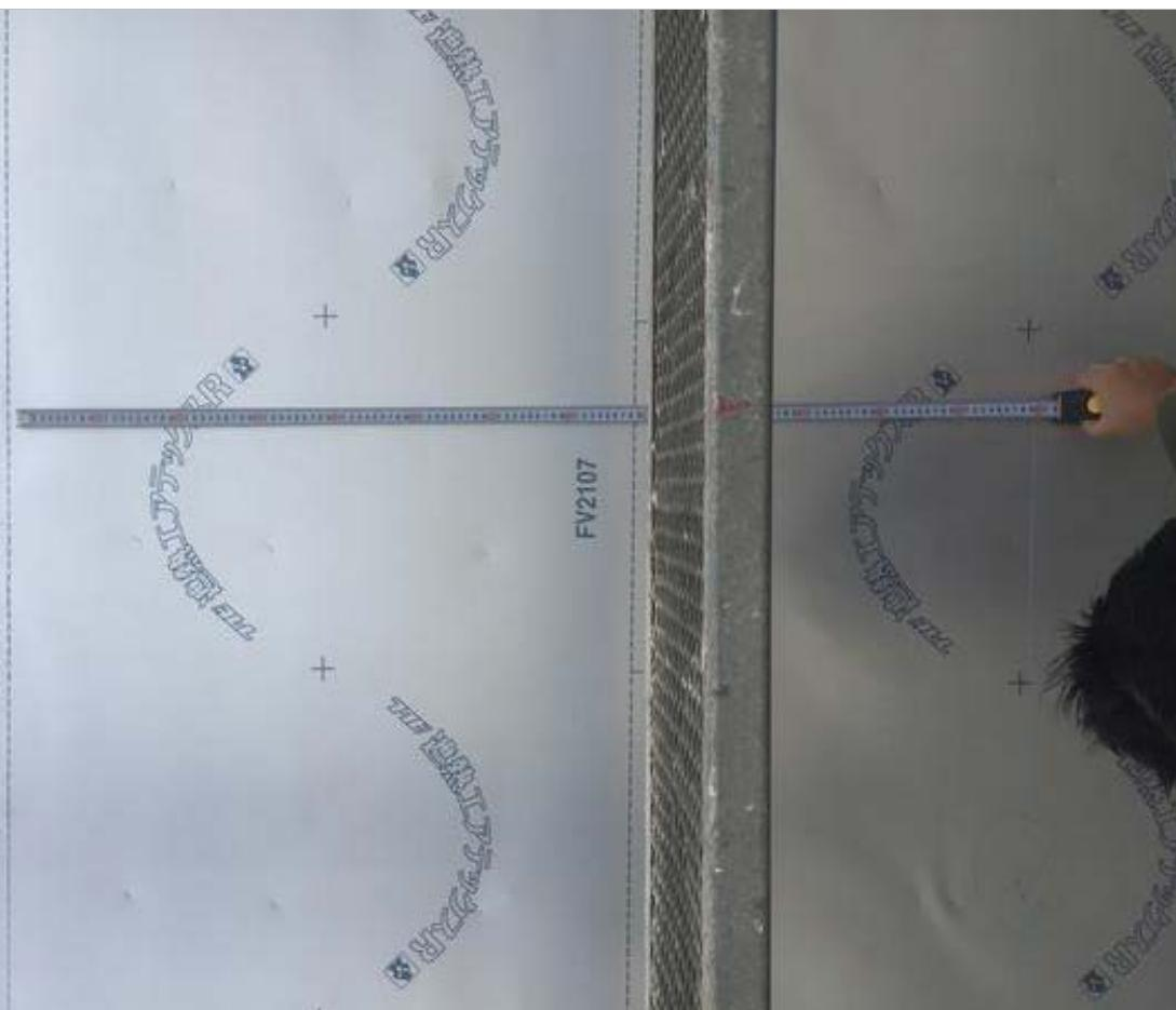
3-8□土台水切り・雨押さえに防水シートを端部に密着させる。
