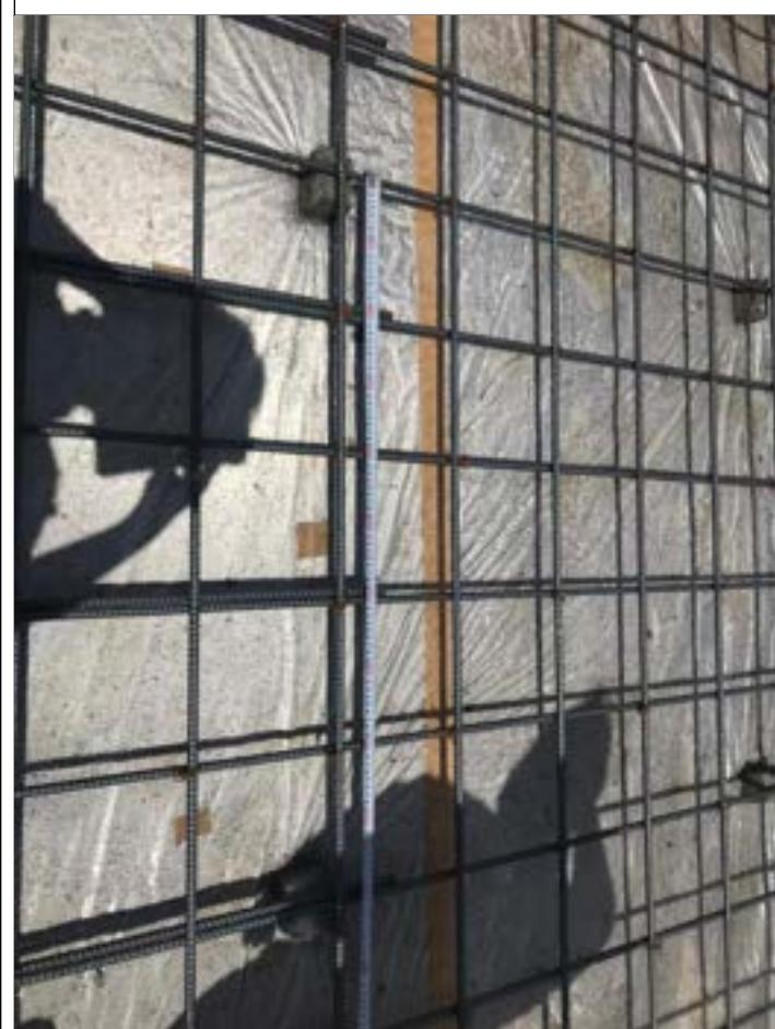
2-8 底盤鉄筋サイコロ（スパンサーブロック）を使いかぶり厚さ60mm以上か
