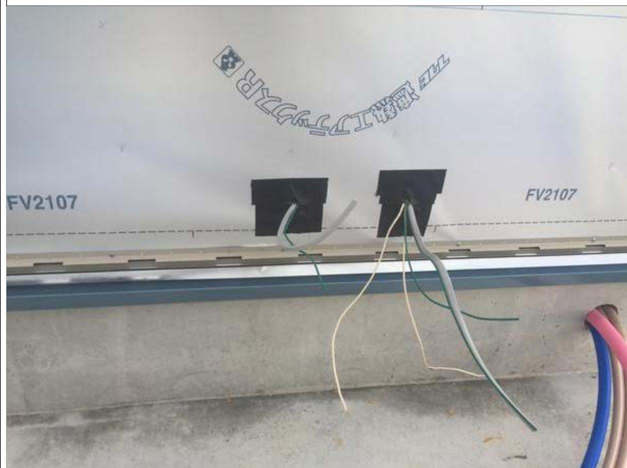
3-9□貫通部の防水措置を適切に処理する。 一体成型品、または防水テープ処置
