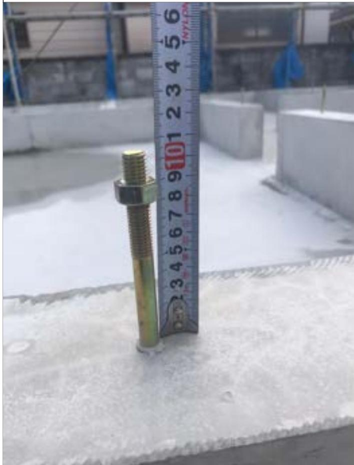
1-2口アンカーボルトのコンクリート埋込み長さは250mm以上とし、アンカーボルトの先端は土台の上端よりナットの外にねじが3山以上出るように固定する。
