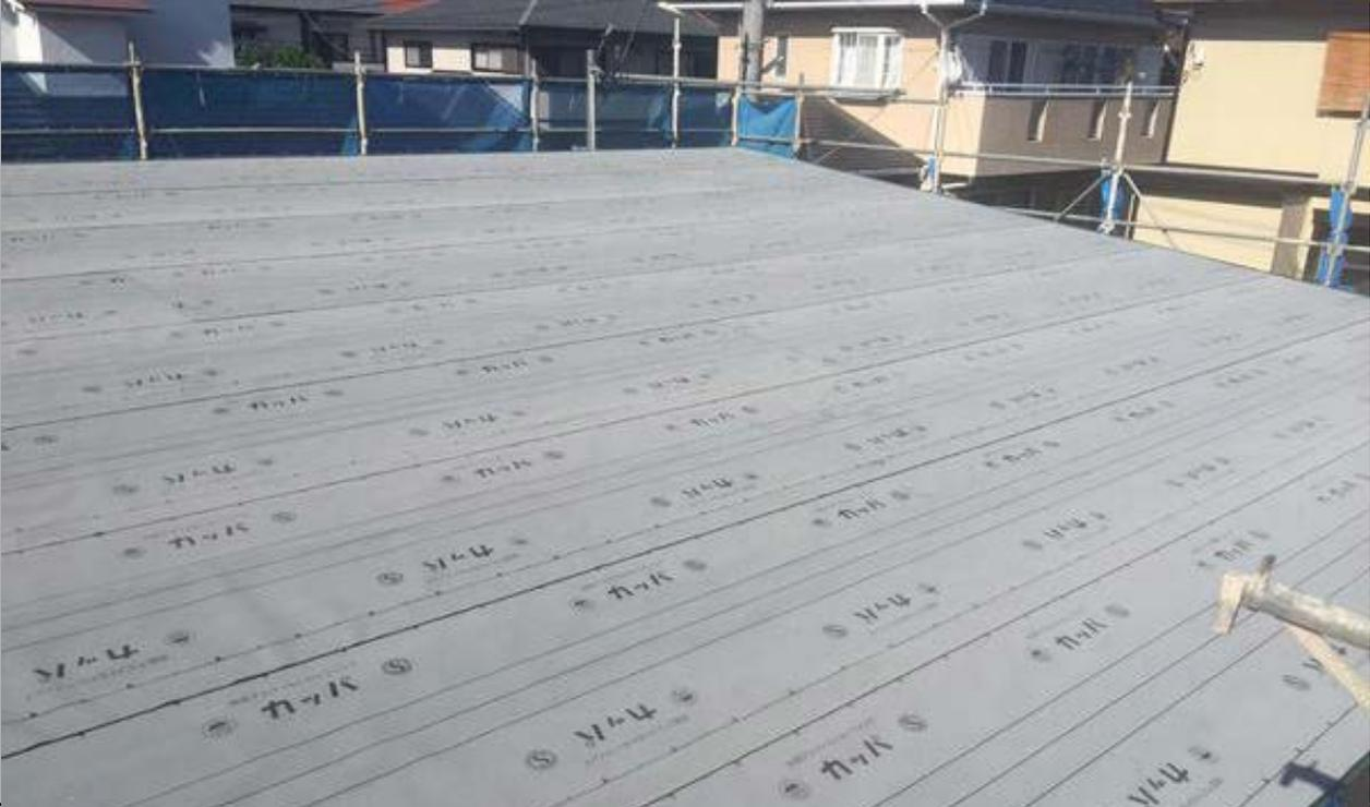
1-23 屋根ルーフィングの立ち上がり250mm以上確保し、上端は気密テープで圧着する。 かつ雨押さえ上端より50mm以上とする
