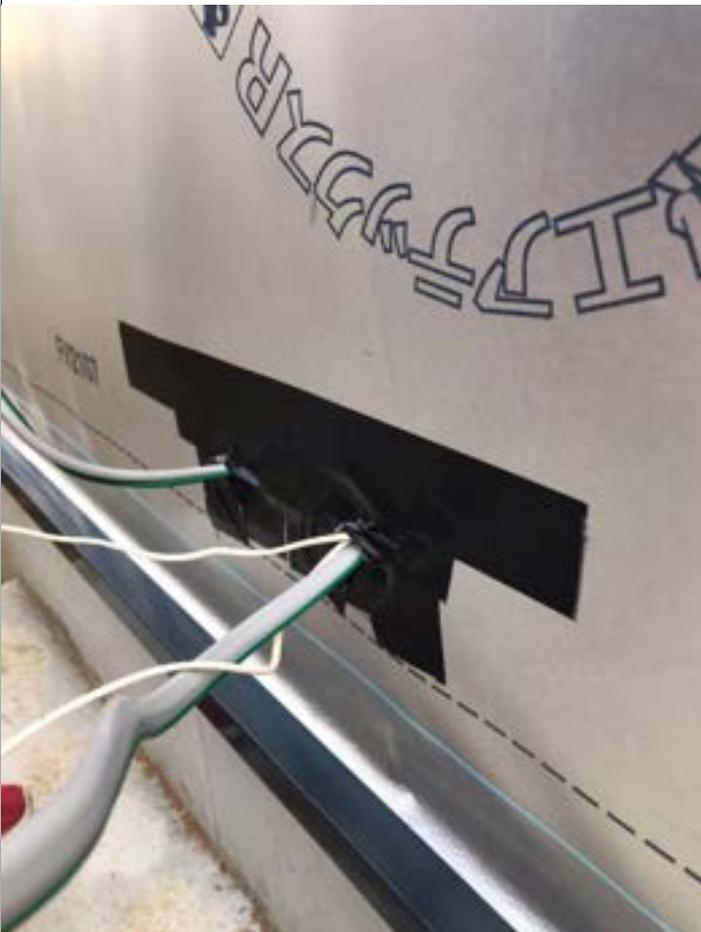
3-9口貫通部の防水措置を適切に処理する。一体成型品、または防水テープ処置
