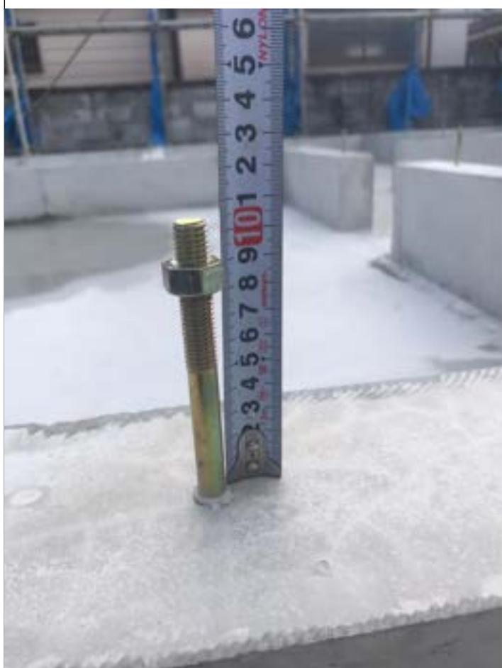
1-5口鋼製束施工前に基礎内を掃除機で掃除する。鋼製束の間隔は前後左右1m以内を保ち、接着剤がはみ出るまで圧着する。
