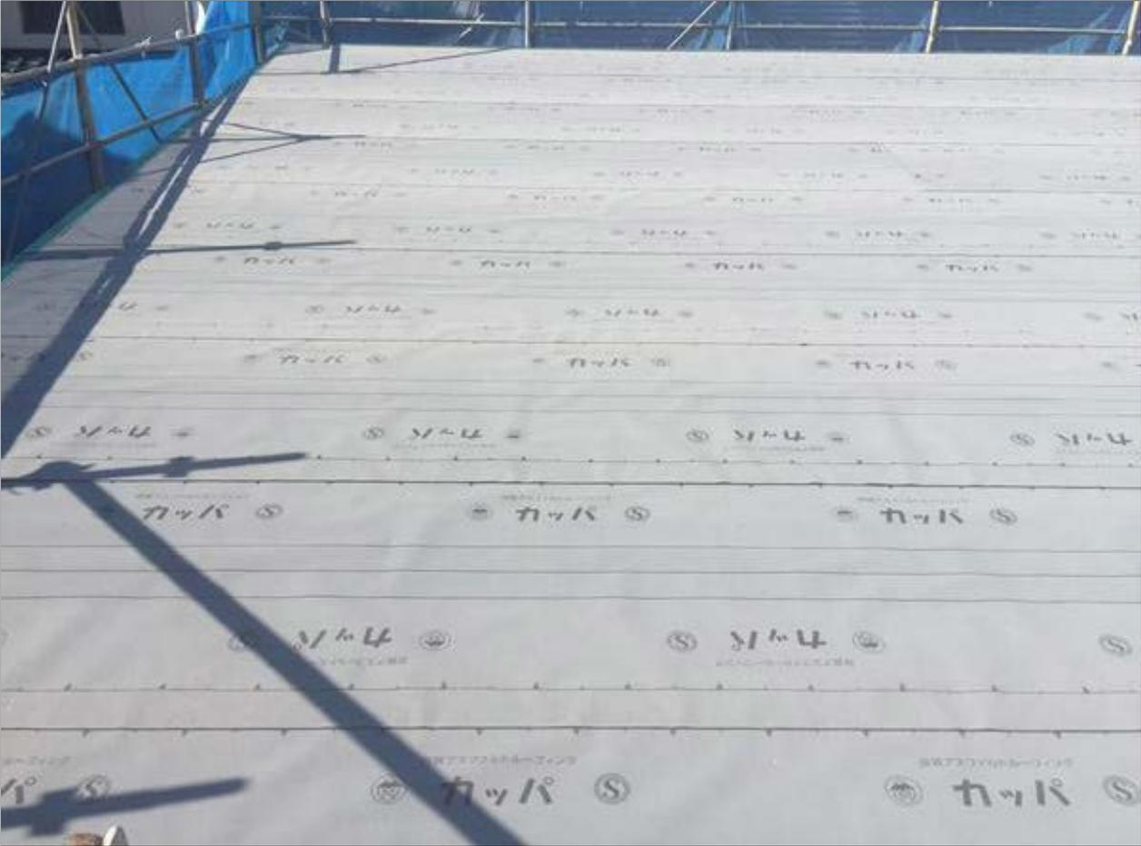
1-22 建て方当時にアスファルトルーフィングまで施工する。上下（流れ方向）は100mm以上、左右（長手方向）は200mm以上重ね合わせる。（未施工の場合、ブルーシート養生する）下屋と外壁の取り合い部に関しては、建て方時にアスファルトルーフィングを先行して差し込んでおく。（ルーフィング施工前に外し釘を確認）(2/2)
