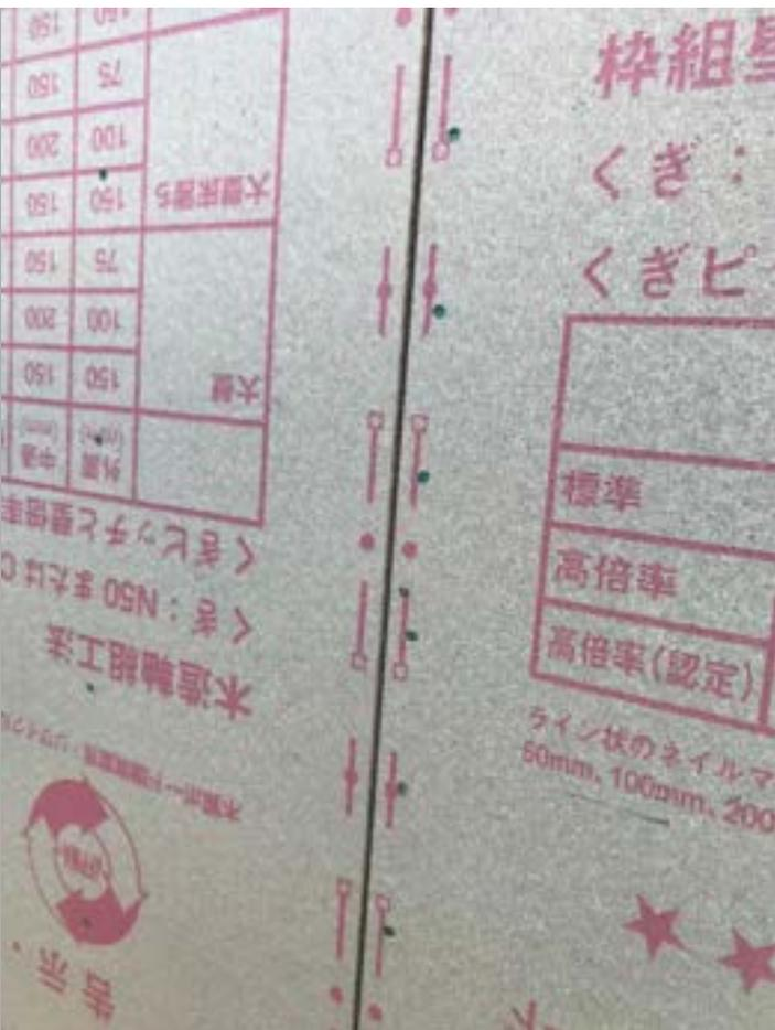
1-10 外壁下張りの釘のピッチはメーカー仕様の壁倍率通りに施工する。
