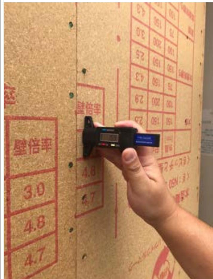
1-13口接合金物の種類・施工位置が図面通りか確認する。
