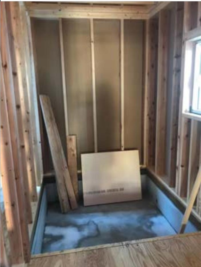
1-7口地面からの高さが1m以内の外壁の枠組の防腐・防蟻措置を現場で塗布・吹付をする。
