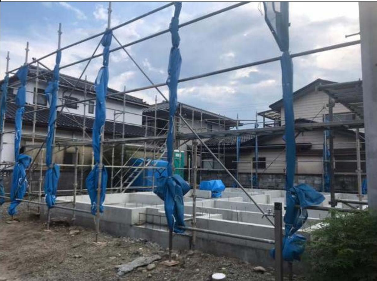
2-16 打ち継ぎ部にジャンカ、空洞及び亀裂等が発生していないか確認する。(2/2)
