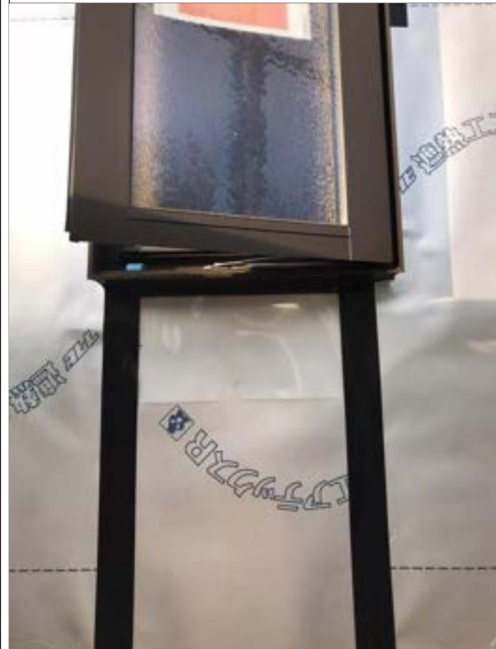
3-4口軒天井と外壁の取り合い部の防水紙張り上げは目安として、軒天井から100mm程度以上、又は小屋裏換気に支障がないところ（垂木下端など）まで張り上げる。
