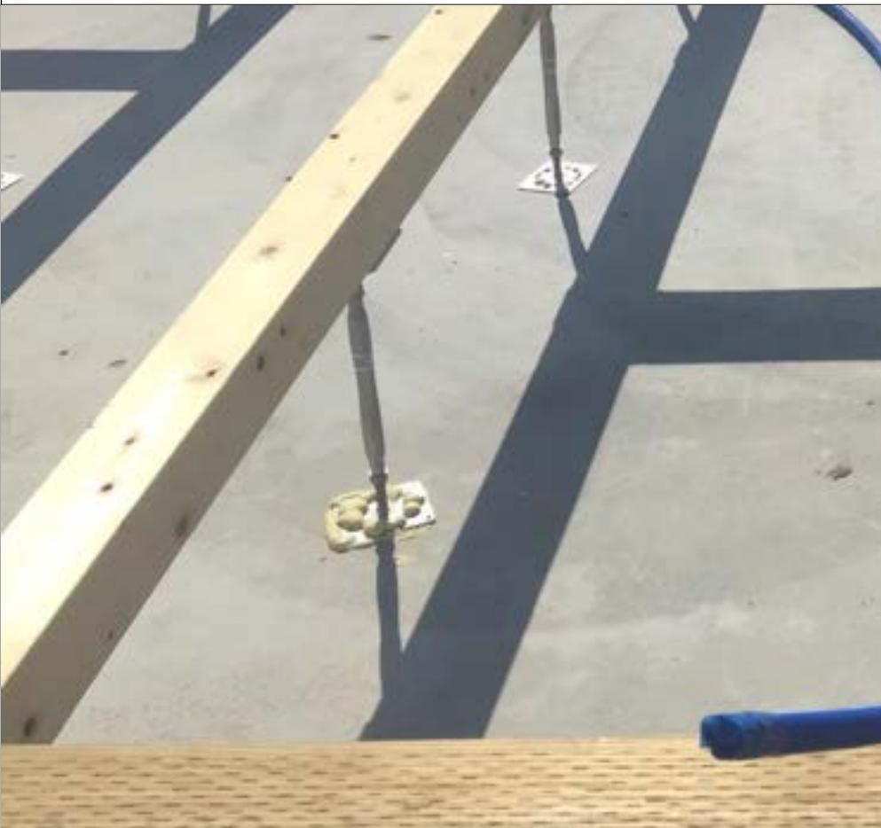
1-6口土台の防腐・防蟻処理材を用いる。（土台に接する外壁の下端には、水切りを設ける）
