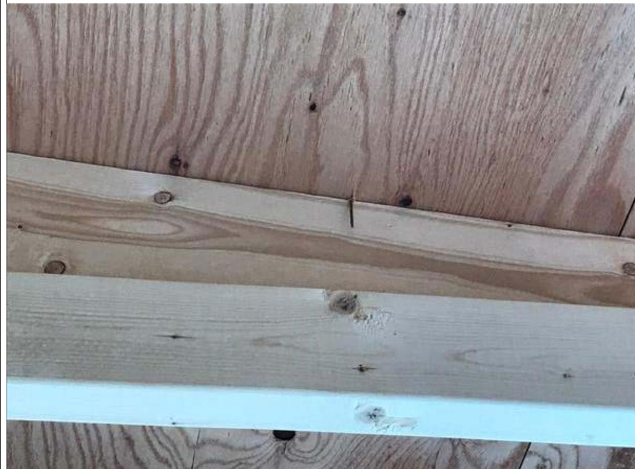
1-22 建て方当時にアスファルトルーフィングまで施工する。上下（流れ方向）は100mm以上、左右（長手方向）は200mm以上重ね合わせる。（未施工の場合、ブルーシート養生する）下屋と外壁の取り合い部に関しては、建て方時にアスファルトルーフィングを先行して差し込んでおく。（ルーフィング施工前に外し釘を確認）(1/2)
