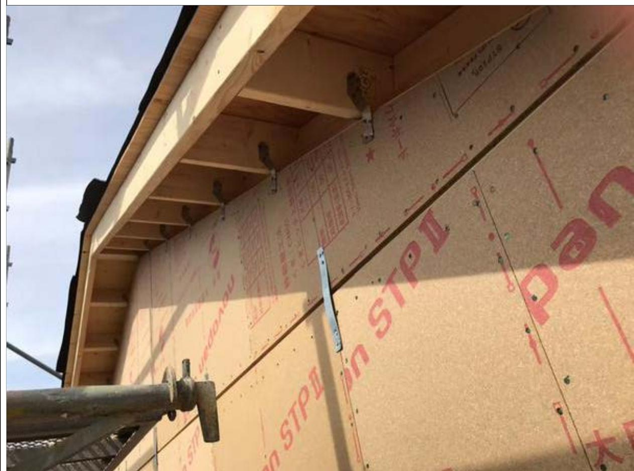
1-13 □接合金物の種類・施工位置が図面通りか確認する。(4/4)
