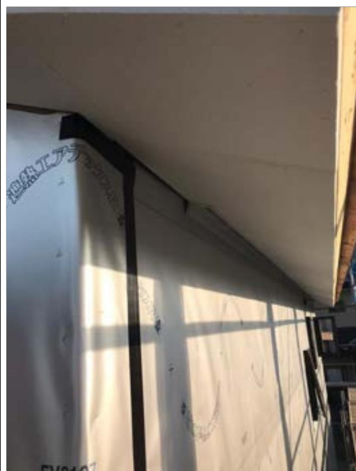
3-5□透湿防水シート（防水紙）の重ね代は、左右150mm、上下90mm以上取る。ステープルのピッチは100mmを目安とする。出入隅部は重ねつくりの施工をし、その際重ね代を150mm以上確保し、かつ重ね部分を乱にする。
