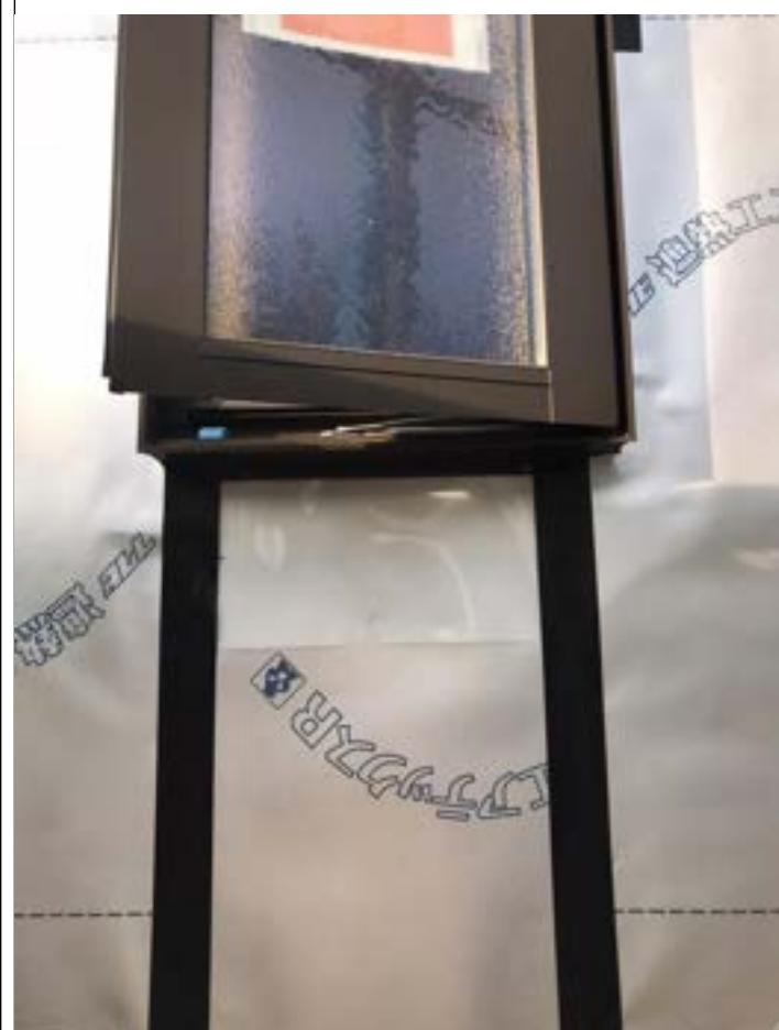
3-7 土台水切りと土台を両面粘着防水テープで張る。雨押さえに両面粘着防水テープを張る。
