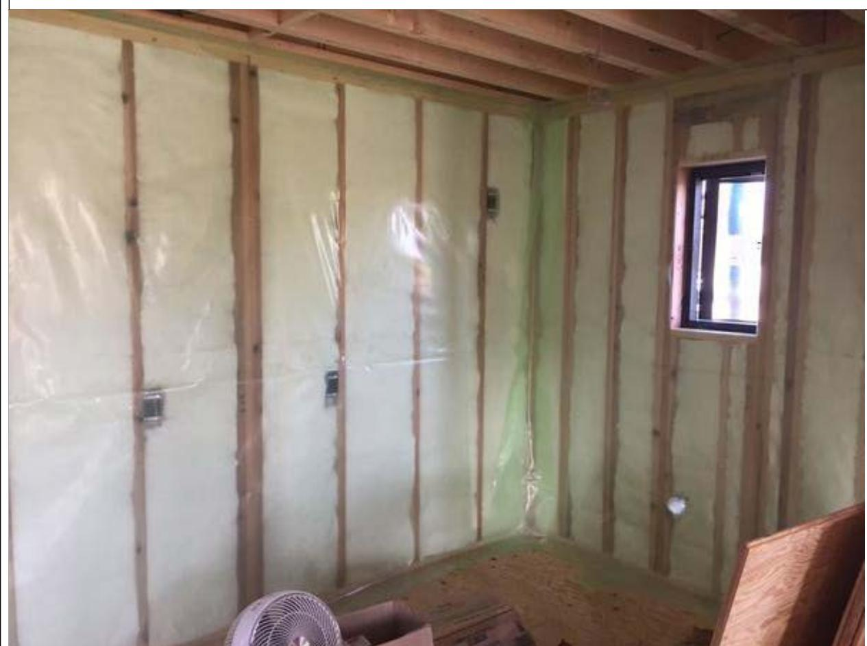
2-1□床・壁・天井（屋根）に図面通りの断熱材を使用する。(4/4)
