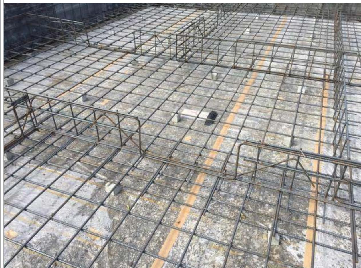
2-8 底盤鉄筋サイコロ（スパンサーブロック）を使いかぶり厚さ60mm以上か
