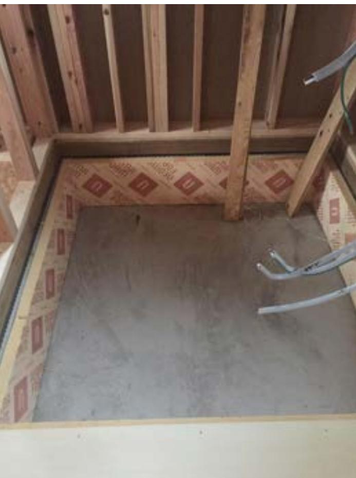
2-5□防湿層（気密シート）は幅広の長尺シートを用い、連続させ、隙間の出ないように施工する。継ぎ目は下地材のある所で30mm以上重ね合わせる。(1/2)
