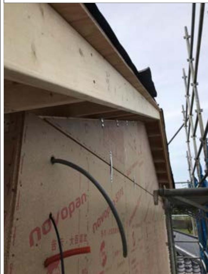
1-11 外壁下張りの釘のめり込み具合2mm以内か確認する。※デプスゲージにて沈み込みの確認。
