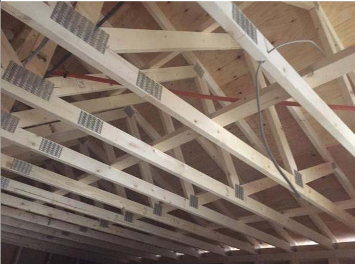
1-13□接合金物の種類・施工位置が図面通りか確認する。(2/4)
