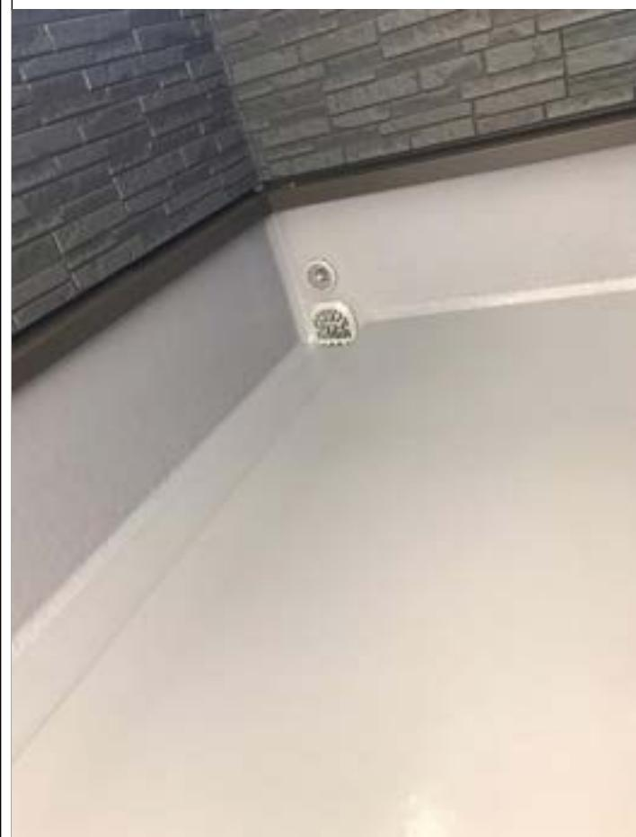
3-14 バルコニー防水層の立上り高さは、外部開口部の下端で120mm以上、
