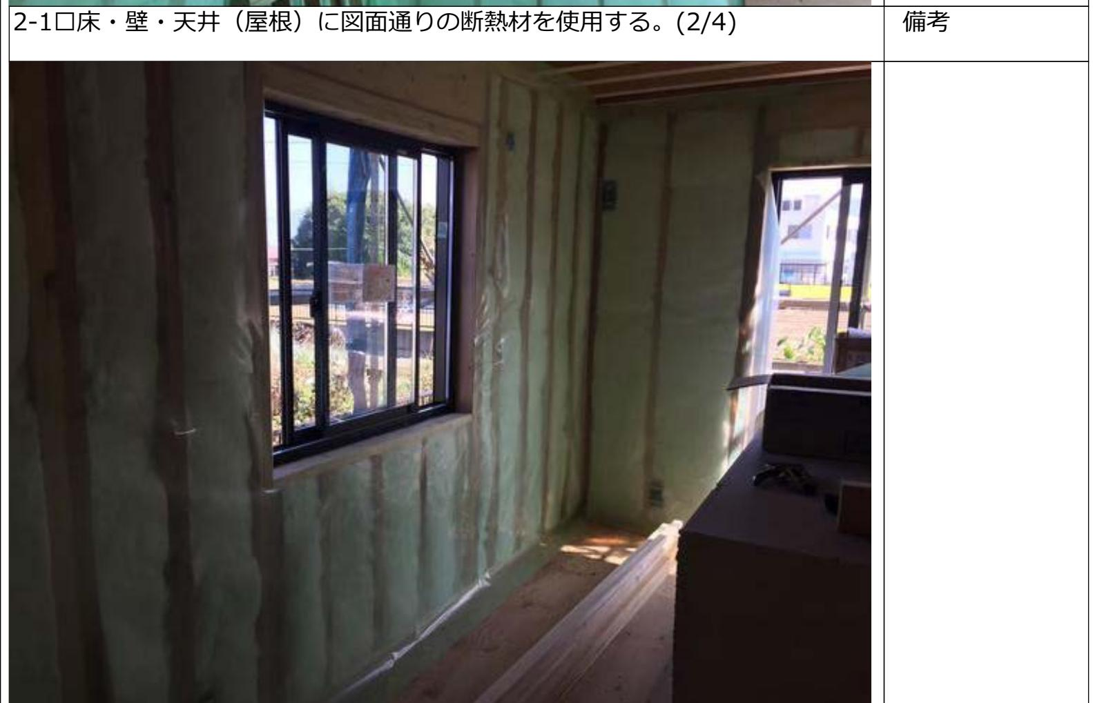
2-1□床・壁・天井（屋根）に図面通りの断熱材を使用する。(3/4)
