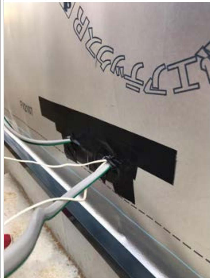
3-9□貫通部の防水措置を適切に処理する。一体成型品、または防水テープ処置
