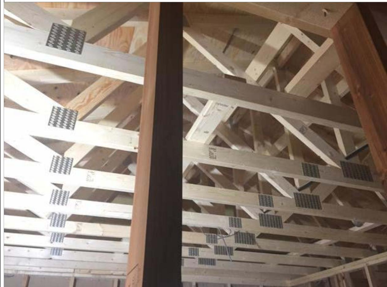
1-13□接合金物の種類・施工位置が図面通りか確認する。(3/4)
