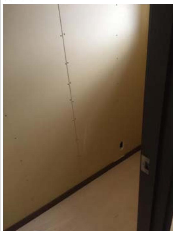
1-16 壁張りに用いるせっこうボードは、床面からの湿気により強度が低下しないように床面から13mm程度離して打ち付ける
