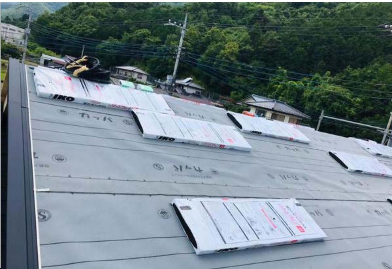
1-23 屋根ルーフィングの立ち上がり250mm以上確保し、上端は気密テープで圧着する。かつ雨押さえ上端より50mm以上とする
