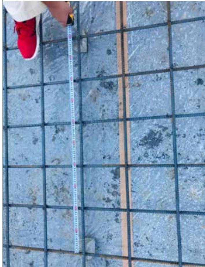
2-8 底盤鉄筋サイコロ（スパンサーブロック）を使いかぶり厚さ60mm以上か
