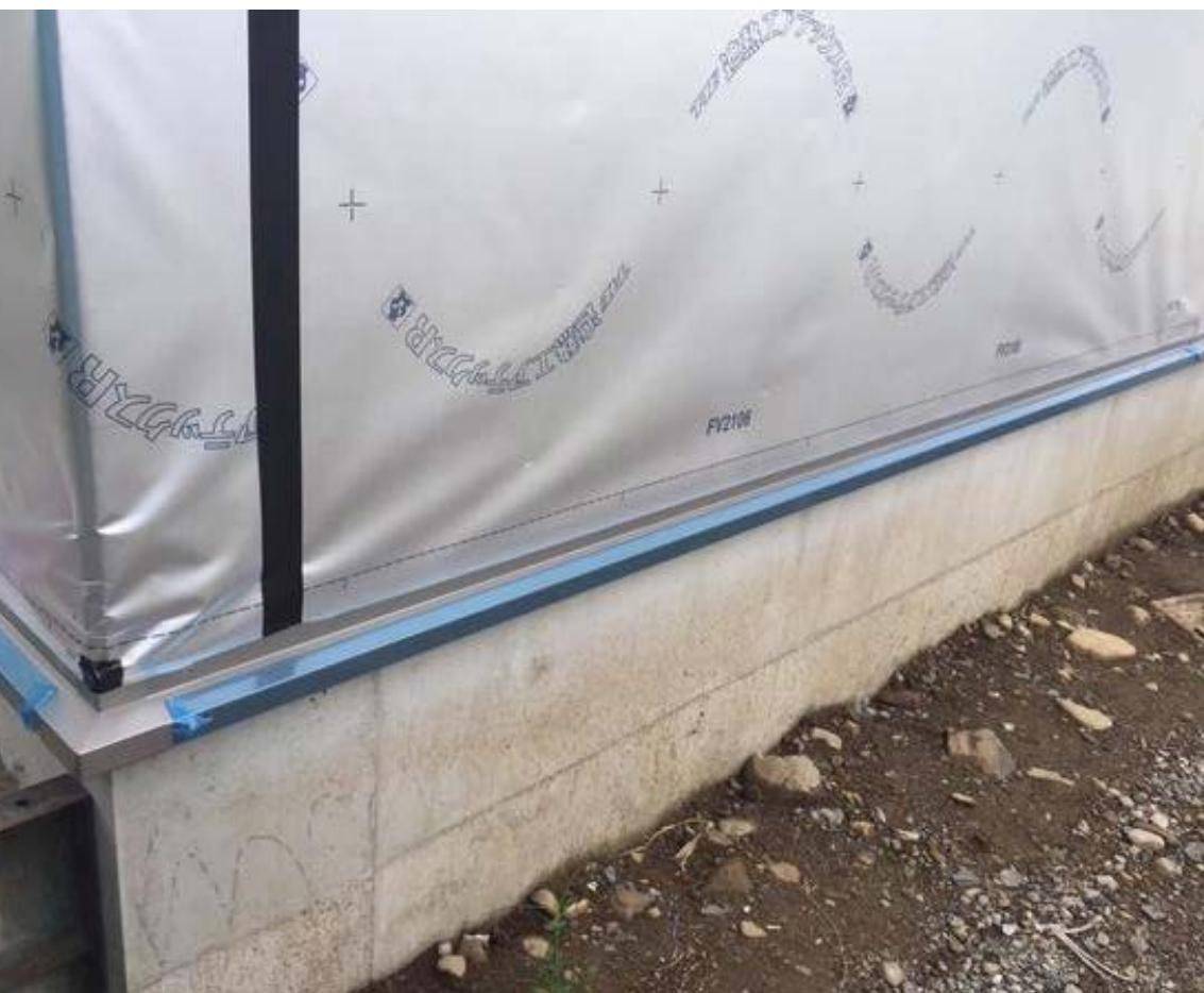
3-9 □貫通部の防水措置を適切に処理する。 一体成型品、または防水テープ処置
