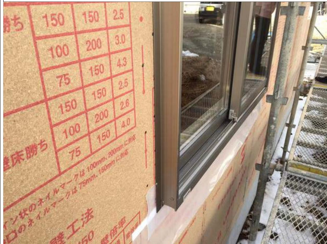
3-2□両面防水テープを用いて、サッシくぎ打ちフィンの根元を十分に覆い、縦・横の防水テープ交差部にすき間が生じないように張る。
