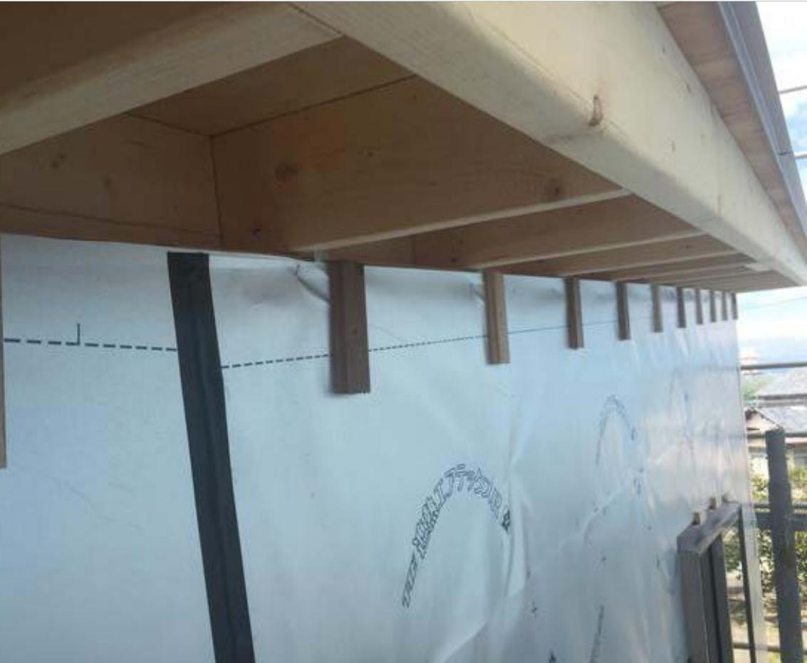
3-7 土台水切りと土台を両面粘着防水テープで張る。雨押さえに両面粘着防水テープを張る。
