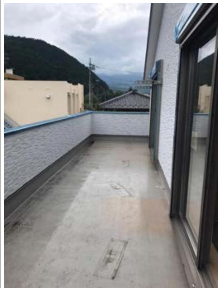
3-15 窯業系サイディング張りの取り付けは、目地通り良く、不陸、目違い等のないように行う。サイディングと土台水切り等の取り合いは、10mm程度の隙間をあける。
