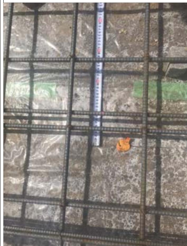
2-3 鉄筋の継手、定着は40d以上とする。参考:D13の場合 520mm
