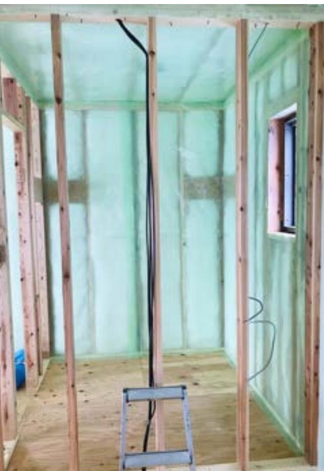
2-3□断熱材は隙間・欠損・施工不良がないように施工する。断熱材は配管部分に隙間ができないように気を付ける。(2/2)
