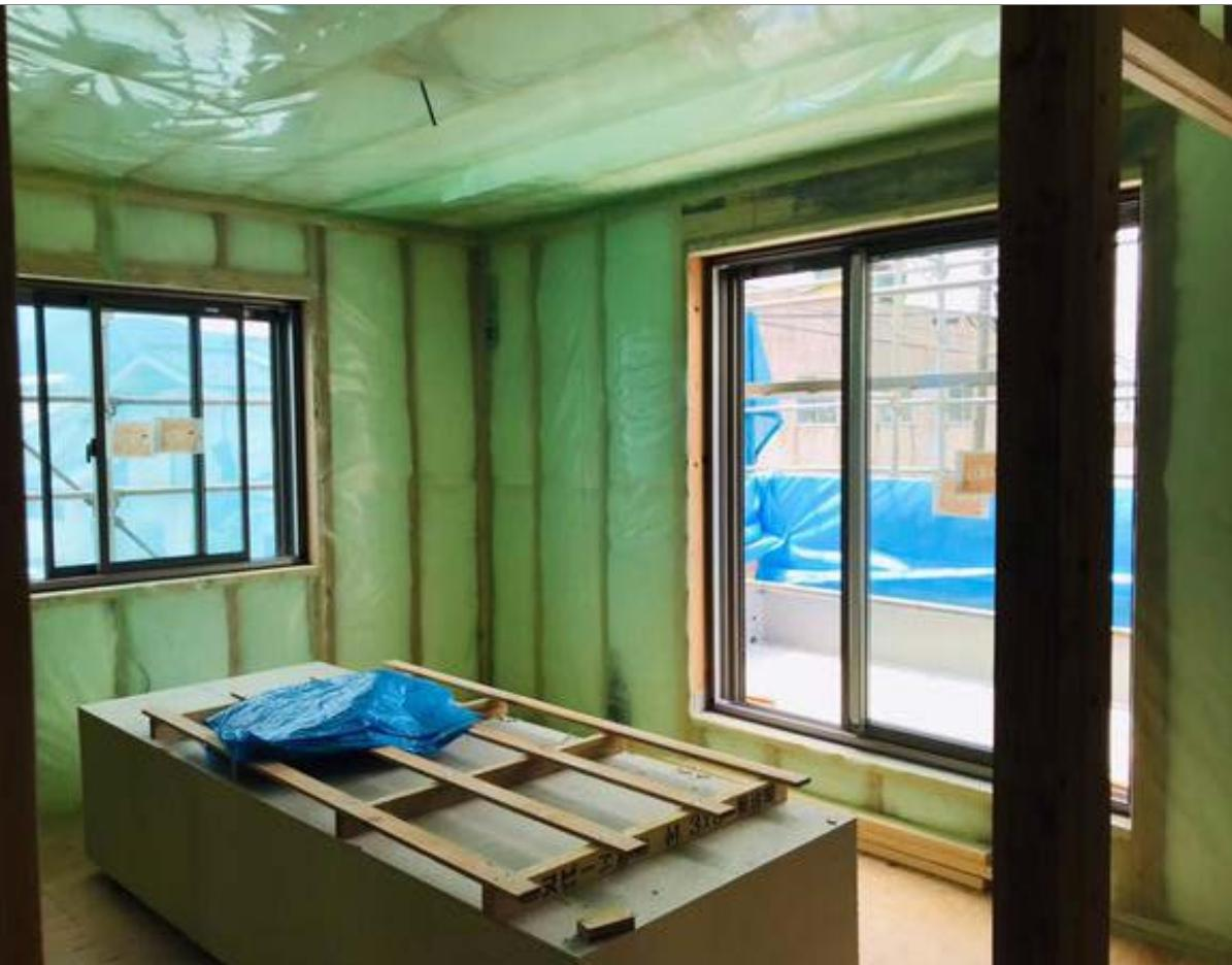
2-3□断熱材は隙間・欠損・施工不良がないように施工する。 断熱材は配管部分
