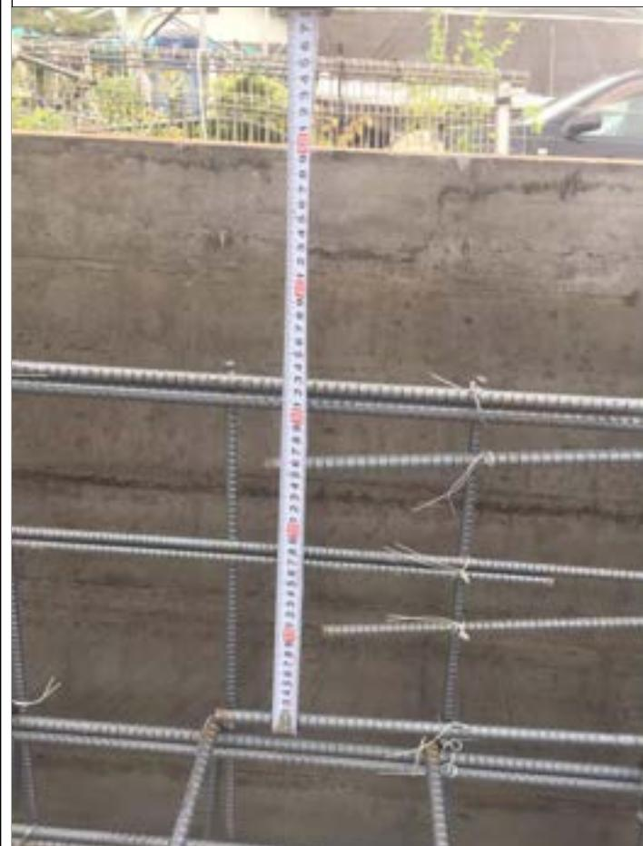
2-14 スリーブ管周辺の切断した主筋と同径の鉄筋を追加し、端部から補強筋の定着長さを40d以上確保する。
