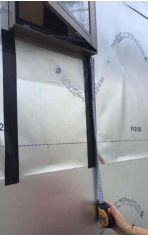
3-7 土台水切りと土台を両面粘着防水テープで張る。 雨押さえに両面粘着防水
