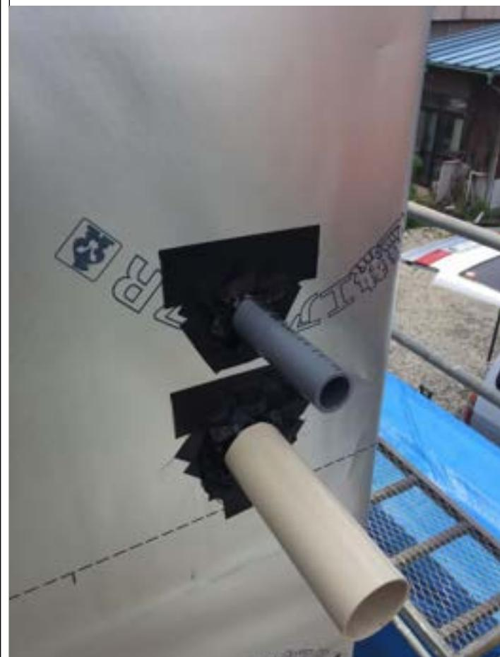
3-9□貫通部の防水措置を適切に処理する。 一体成型品、または防水テープ処置
