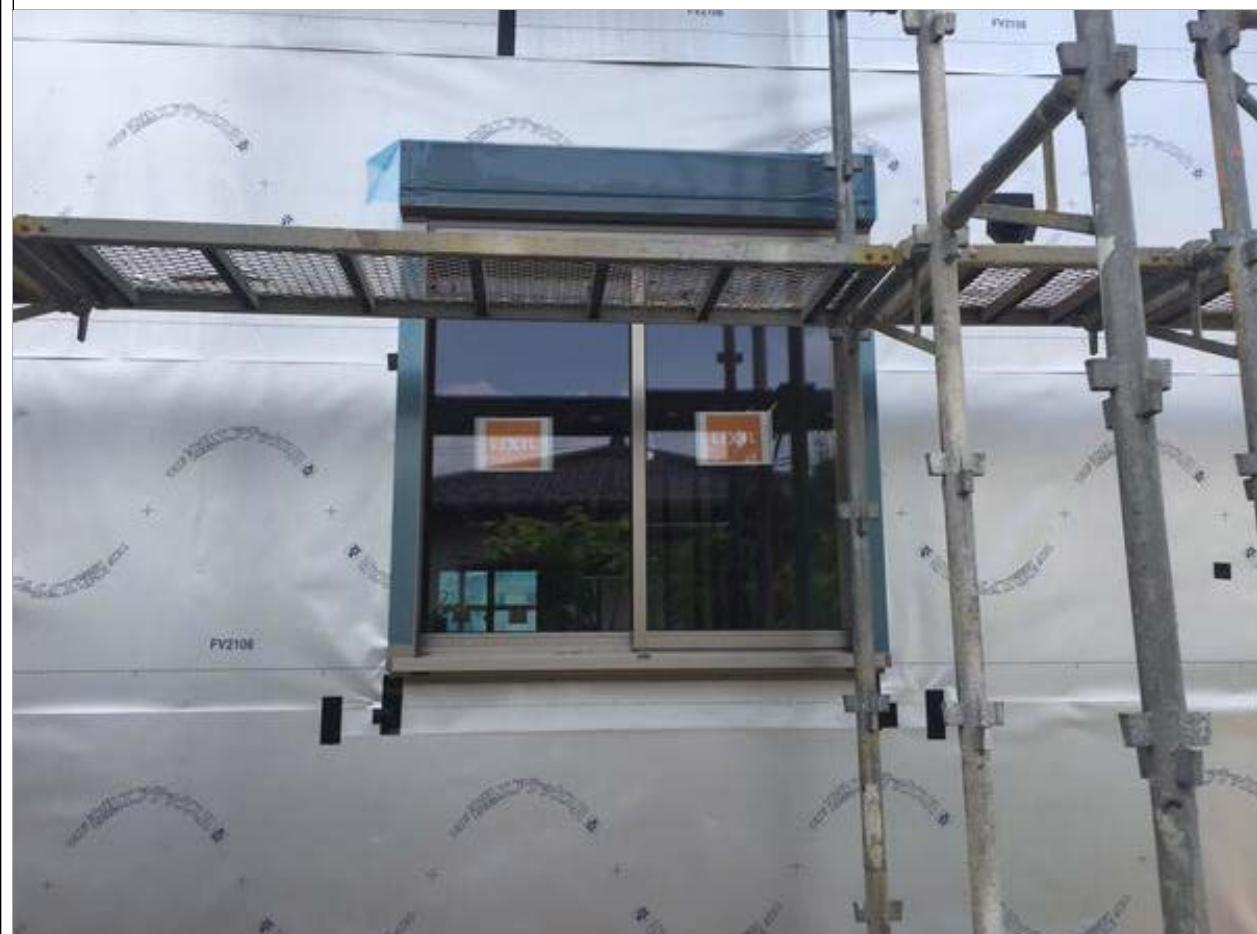
3-5□透湿防水シート（防水紙）の重ね代は、左右150mm、上下90mm以上取る。ステープルのピッチは100mmを目安とする。出入隅部は重ねつくりの施工をし、その際重ね代を150mm以上確保し、かつ重ね部分を乱にする。(1/2)
