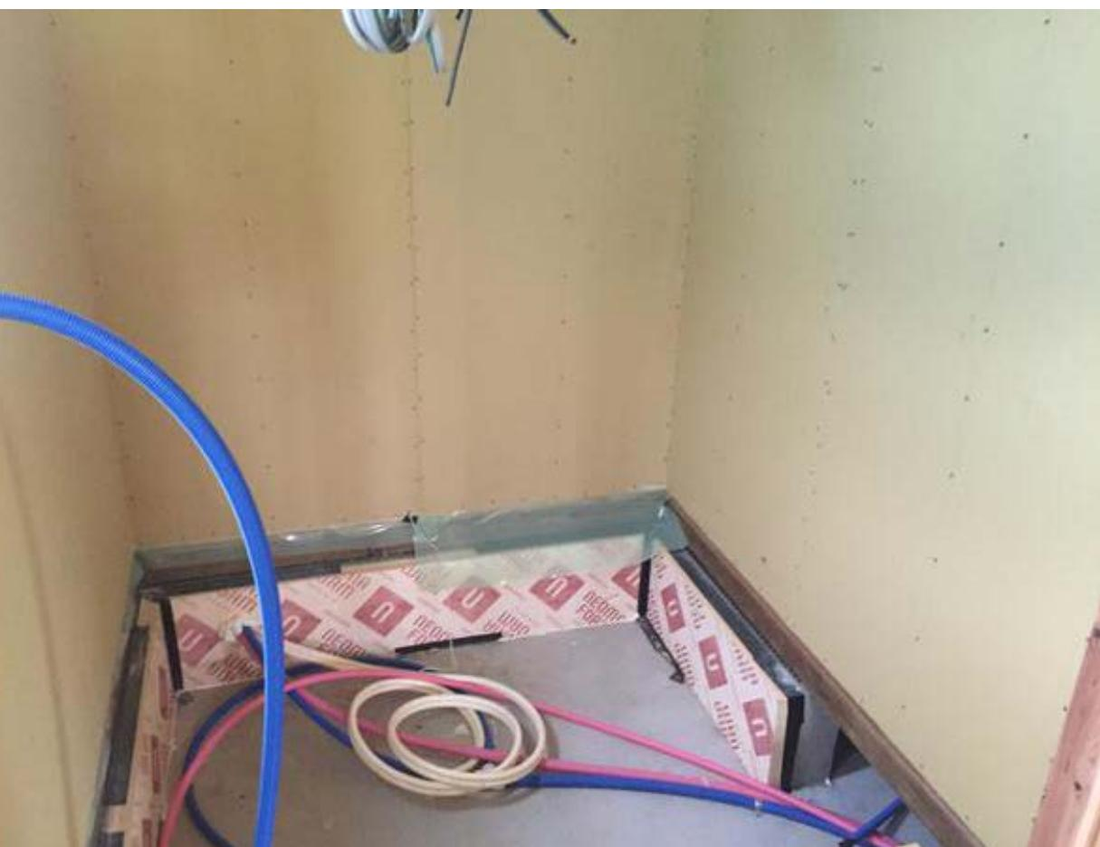
2-5□防湿層（気密シート）は幅広の長尺シートを用い、連続させ、隙間の出ない
