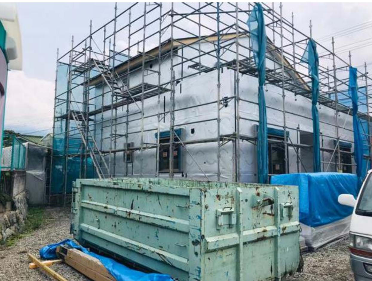
3-5□透湿防水シート（防水紙）の重ね代は、左右150mm、上下90mm以上取る。ステープルのピッチは100mmを目安とする。出入隅部は重ねつくりの施工をし、その際重ね代を150mm以上確保し、かつ重ね部分を乱にする。(2/2)
